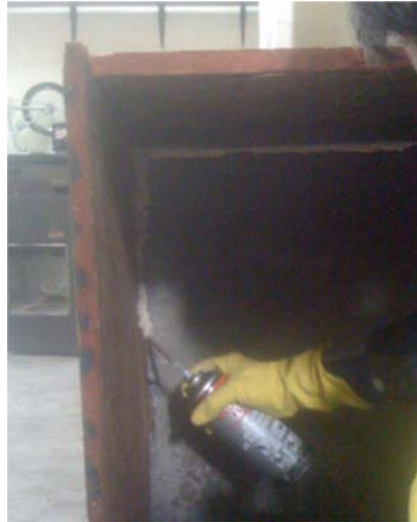
Ilustración N°31: Relleno con poliuretano en espacios vacíos Fuente: Elaboración propia
