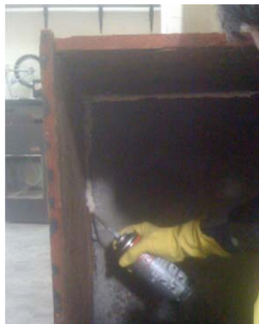
Ilustración N°34: Relleno con poliuretano espacios vacíos Fuente: Elaboración propia
