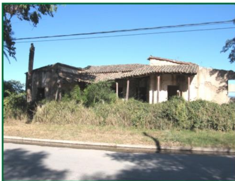
Imagen 31: Tipología de vivienda con galería en "U" en fachada sobre calle principal. Autor: Efraín Lema
