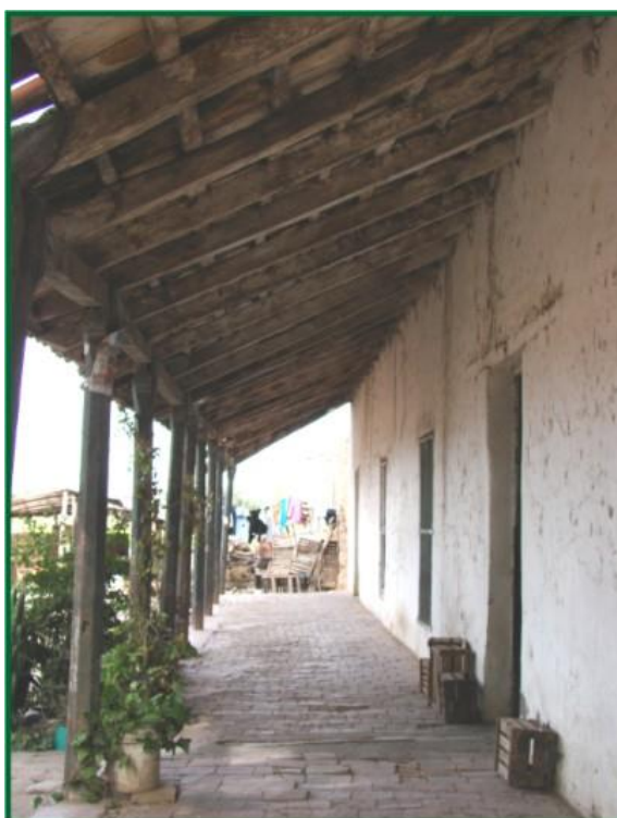
Imagen 20: Vista del interior de la galería Casa de la finca La Ramada. Autor: Orlando Vilariño (DePAUS)
