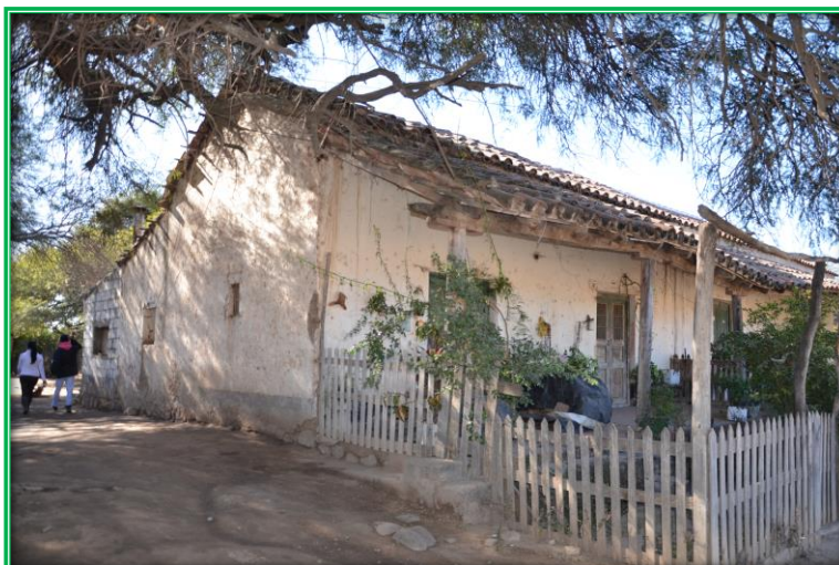
Imagen 41 : Vivienda rural en Cobos. Patologías en muros, estructura de techo y cubierta. Autor: Efraín Lema
