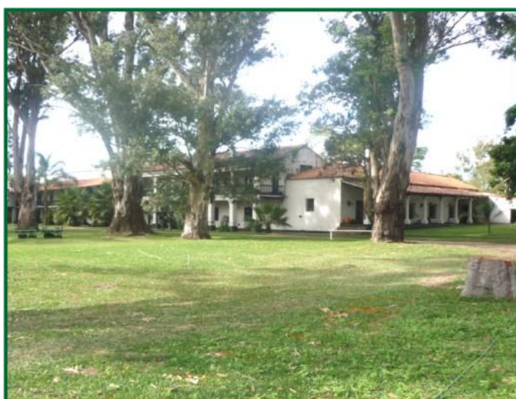
Imagen 24: Vista actual de la casona del Ingenio San Isidro, donde funciona el área de administración. Autor: Efraín Lema
