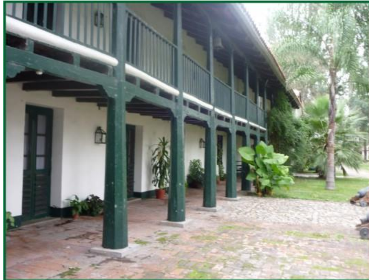
Imagen 21: Vista de la casona del Ingenio San Isidro, sector original . Autor: Efraín Lema
