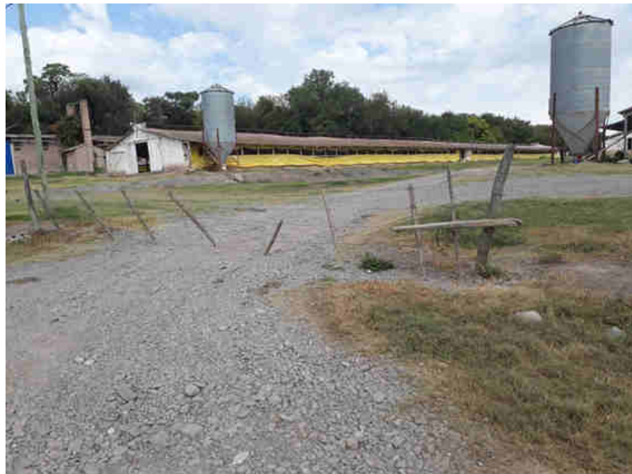
Fig. 6. Cerco perimetral en malas condiciones.
