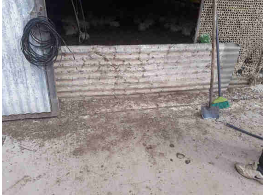
Fig.17. Entrada del galpón con acumulación de suciedad.
