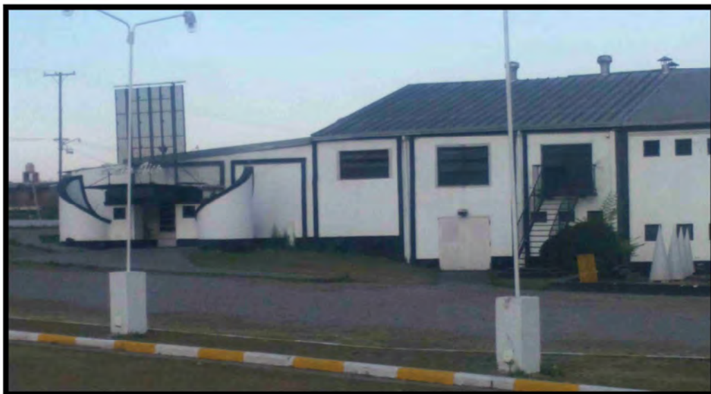
Fotografía 5 Toma vista interna sector playa de estacionamiento y entrada principal a recinto bailable club Retro disco
