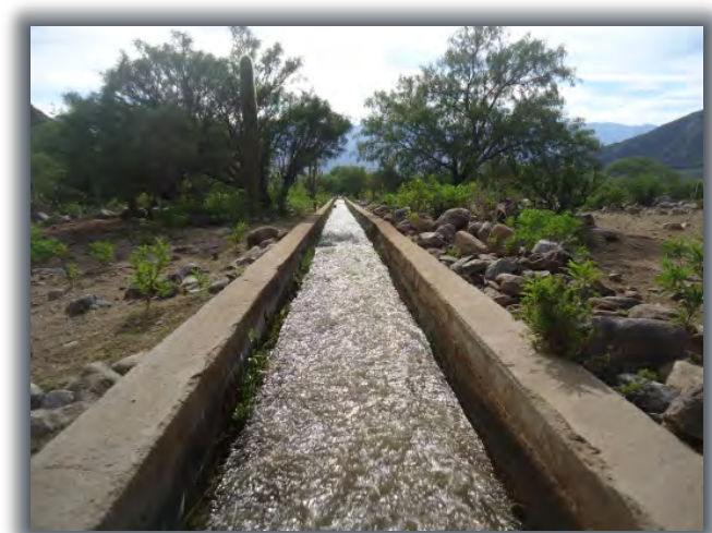
Imagen 4: Canal de Hormigón
