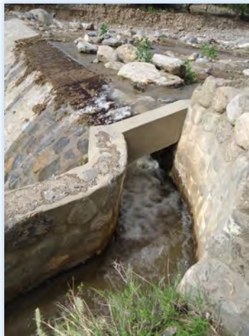
Imagen 29: Toma (Reja, canal de captación y canal de conducción)
