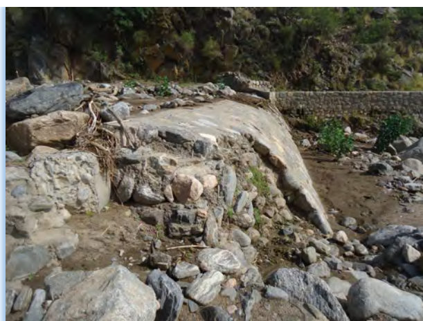
Imagen 3: Detalle margen derecho de toma actual
