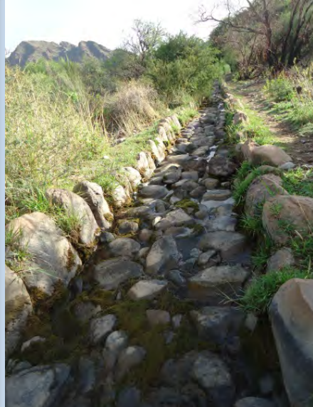
Imagen 5: Canal de mampostería de piedra con junta tomada
