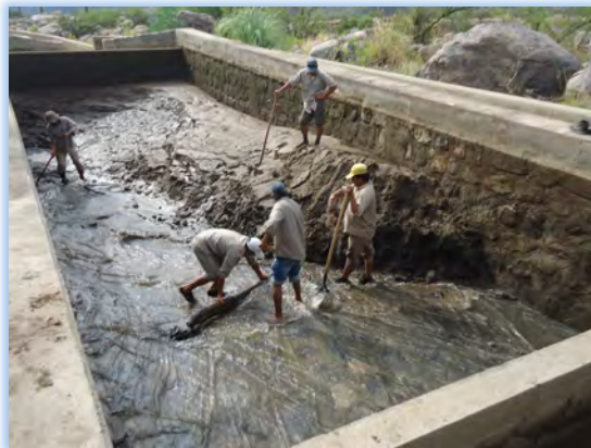
Imagen 9: Desarenador - Tareas de Mantenimiento
