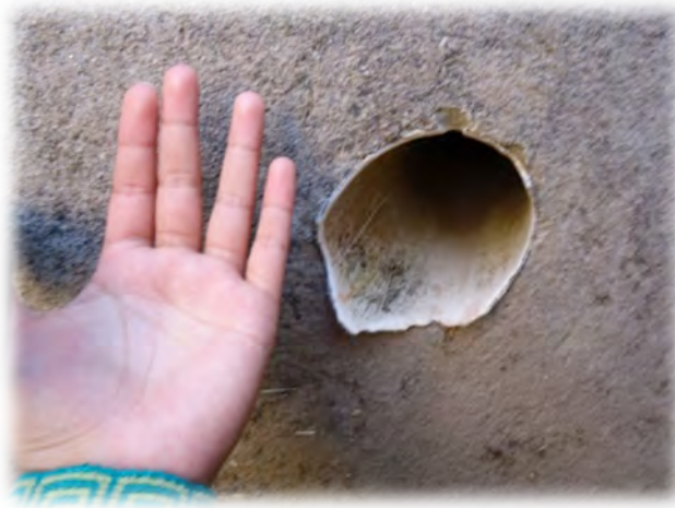
Imagen 12 : Cañería de entrada al desarenador.
