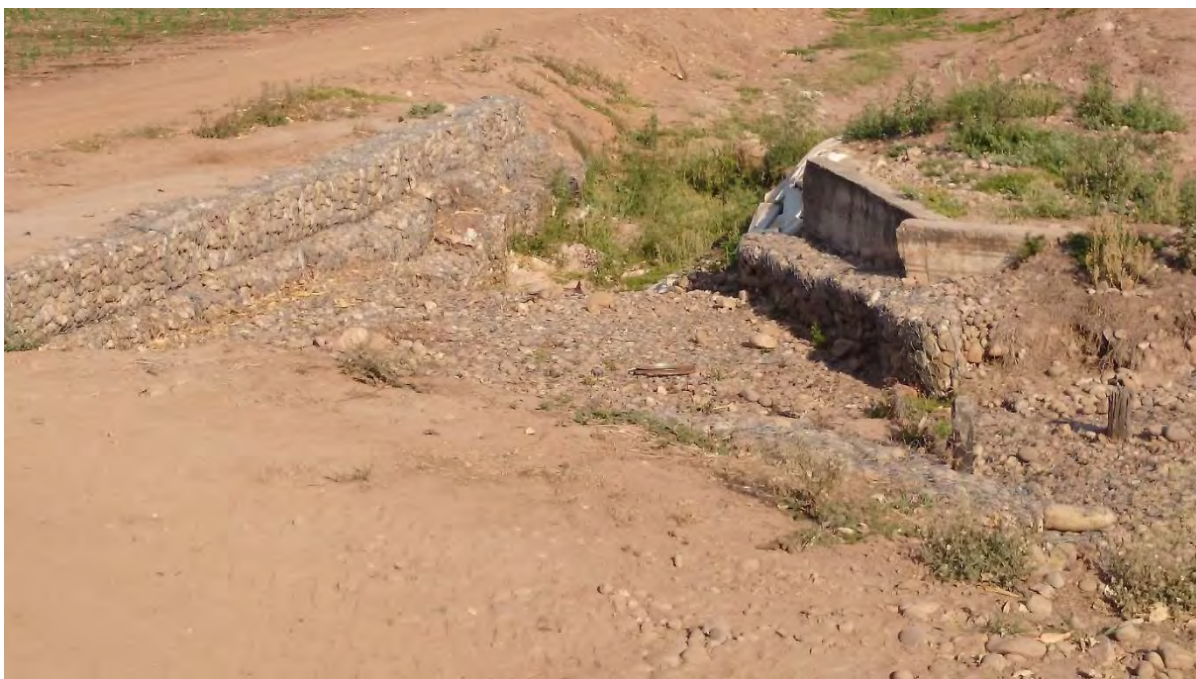
Imagen 6: Obra de arte. Prog 15+000.00 - Tramo fuera del alcance del proyecto
