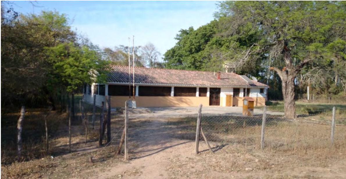
Imagen 10: Escuela N° 4667 - Paraje Zanja del Tigre. Prog 14+500.00.
