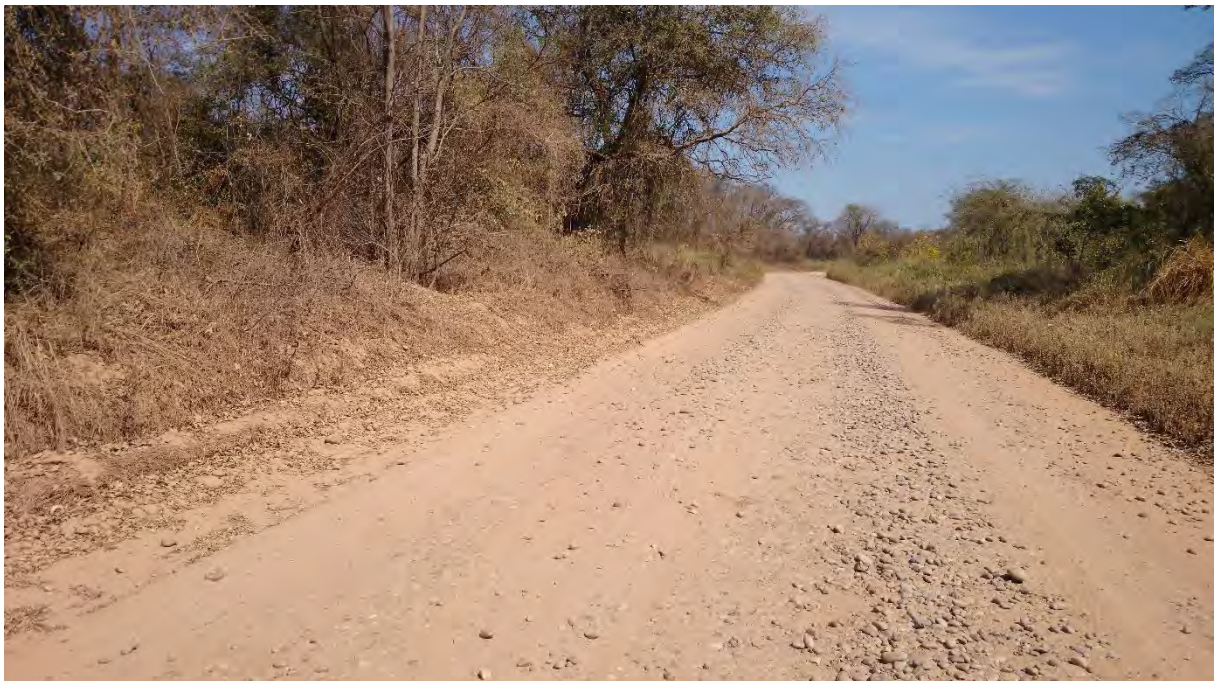
Imagen 5: Progresiva 1+000.00. Vista Sur-Oeste.
