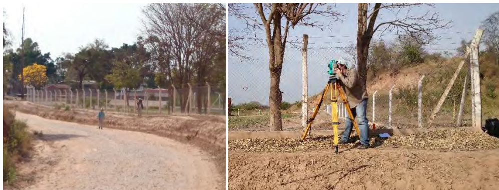
Imagen 15: Relevamiento intersección RN N° 34 y PF 2
