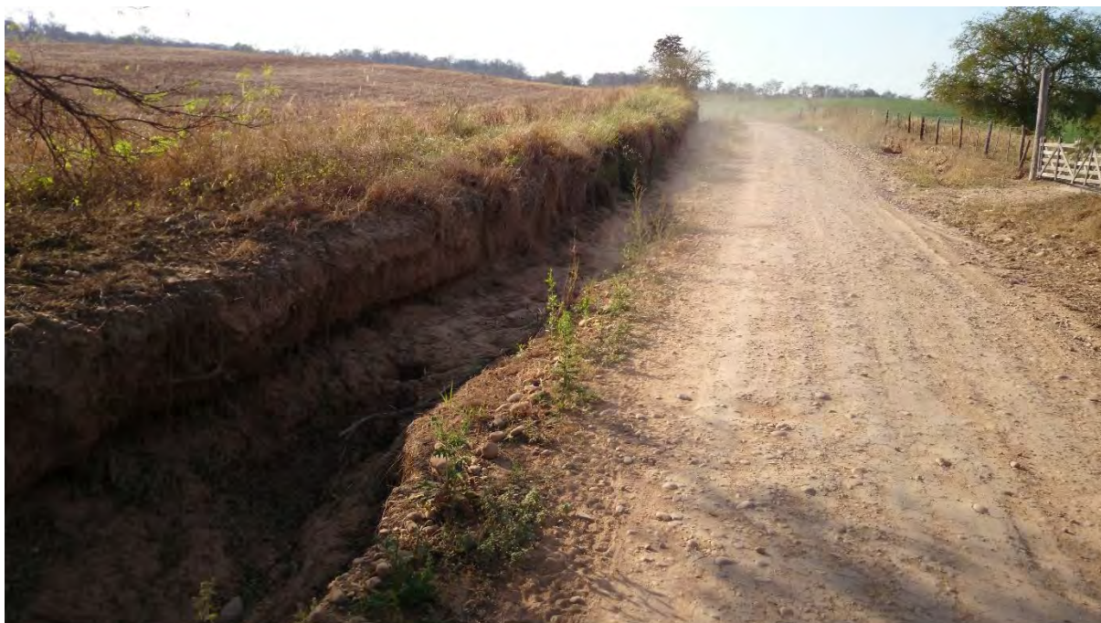
Imagen 9: Prog. 4+400.00. Vista contraria al sentido de progresiva.
