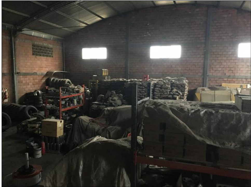
Ilustración 35. Disposición actual del depósito.
