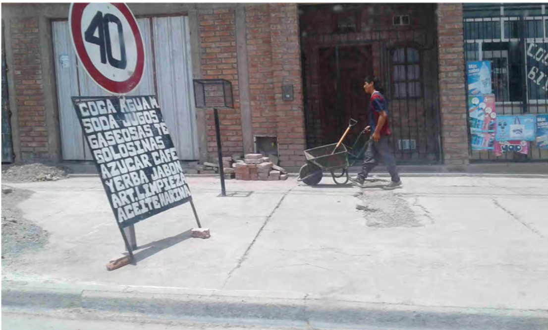
Foto N° 6: Cerramiento del almacén debido a la inseguridad y trabajos precarios.
