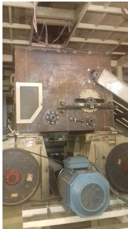
Ilustración 25: montaje de sistema de distribución
