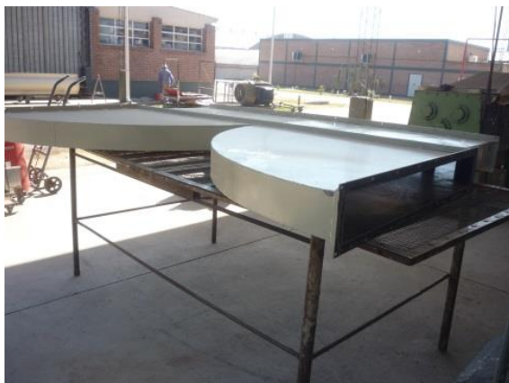
Ilustración 18: Construcción de conducto neumático nuevo
