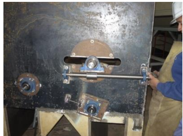
Ilustración 17: construcción de sistema de distribución
