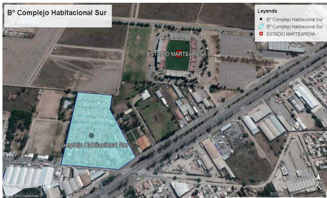
Foto 12: Complejo habitacional Sur
