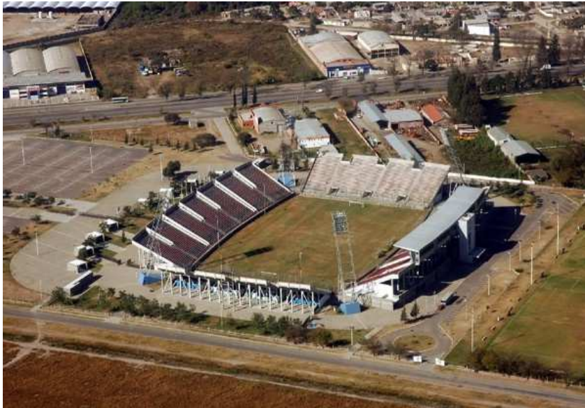
Foto 9. Estadio Martearena Vista aérea. Fuente: Internet
