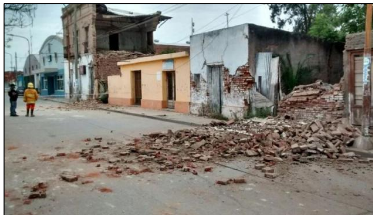
Figura 1.5: Foto del sismo en la localidad del galpón 2
