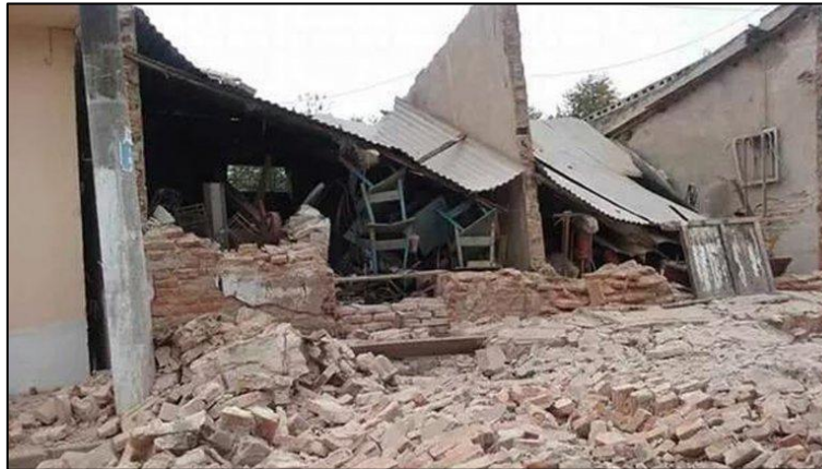
Figura 1.4: Foto del sismo en la localidad del galpón 1
