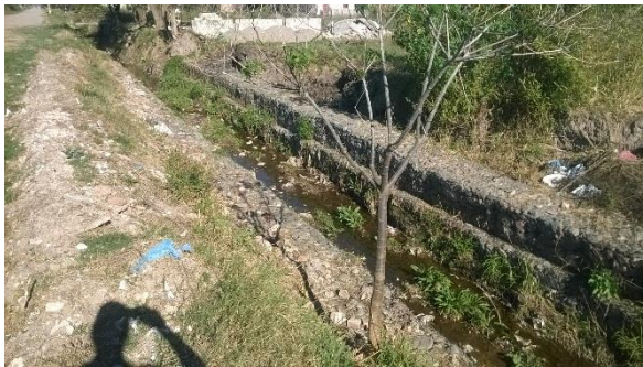
Ilustración 5 - Canal construido con Gaviones
