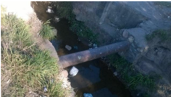
Ilustración 12 - Cañería que atraviesa el canal
