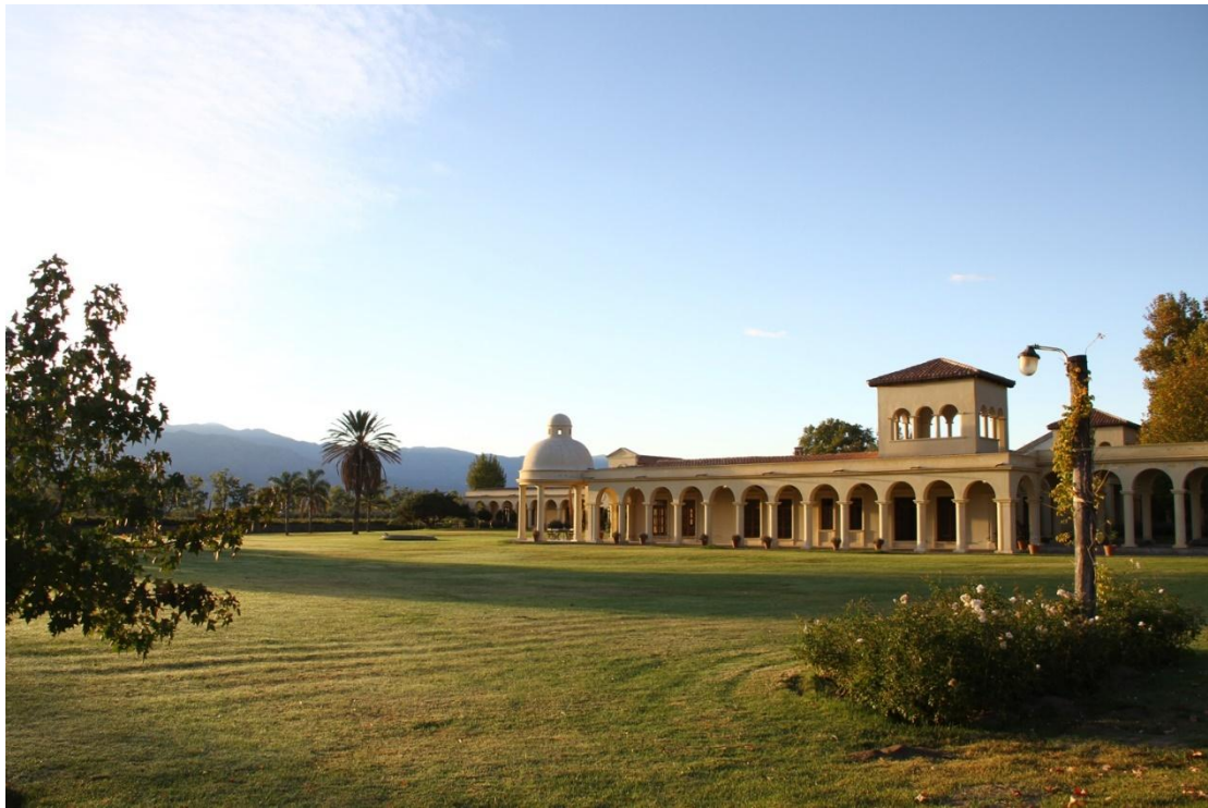
Imagen N° 8 - Fotografía panorámica del frente de la bodega, Finca Quara 38
