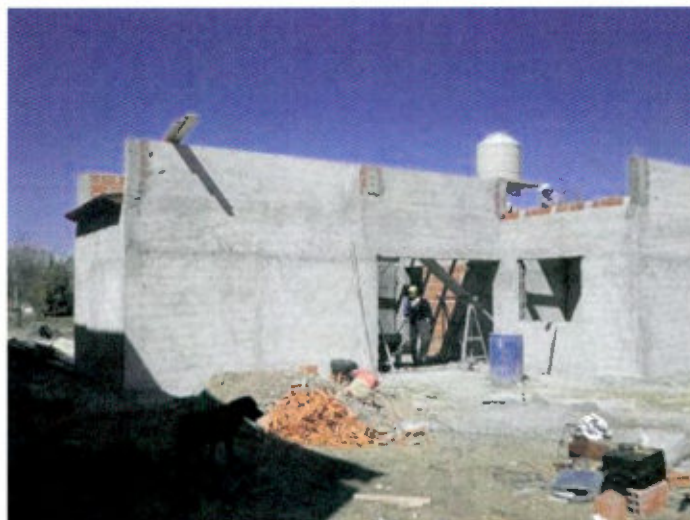
Fig. 13- Foto Instancia de verificación segundo avance de Obra para solicitar el tercer desembolso.
