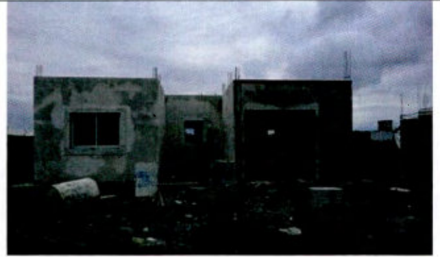
3° INSPECCION AVANCE OBRA estimado del 66% califica para solicitar el 3° desembolso superficie de 80 m 2 con proyecto del cliente.
