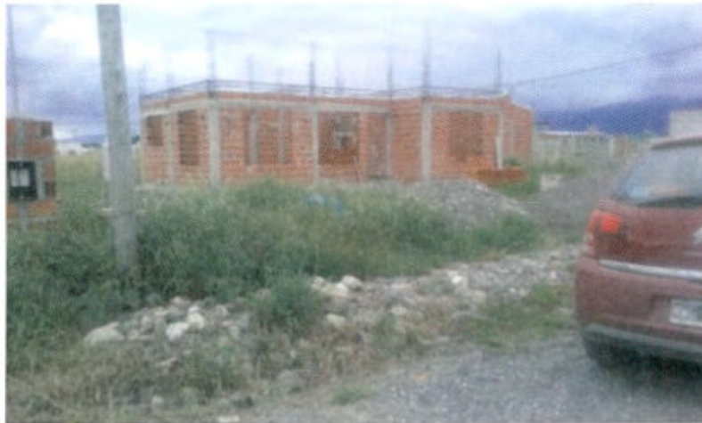
Figura 12- Foto Instancia de verificación primer avance de Obra para solicitar el segundo desembolso
