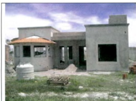
Figura 4- Foto Obra en ejecución según de proyecto libre propuesto por el Cliente
