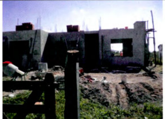
AVANCE DE OBRA Vivienda Unifamiliar Proyecto del cliente, vivienda de 80 a 120 m 2
