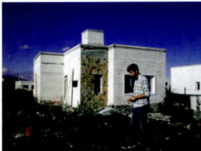
Fig. 31 Instancia de verificación ejecución de Obra Fina para solicitud del tercer desembolso
