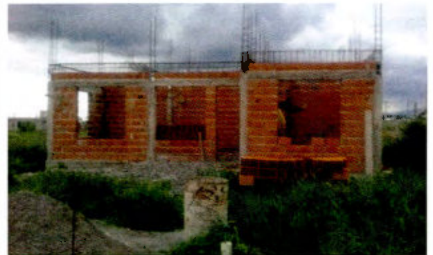
AVANCE del 33 % CAJA MURARIA apto para la solicitud de 2° desembolso Viv. 80 m2
