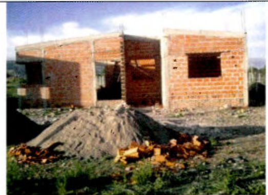
2° INSPECCION CAJA MURARIA: Verificación de 33% de avance de obra en viviendas con superficies
