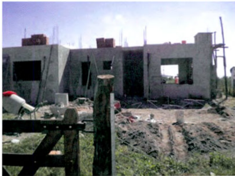
Fig. 20- Foto Instancia de verificación ejecución de Obra Gruesa para solicitud del segundo desembolso
