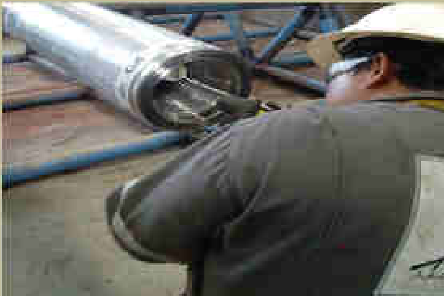
Con limpieza adecuada se puede proceder a realizar inspección visual
