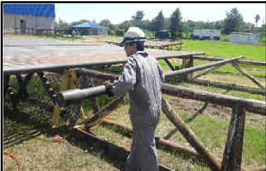
Barra de sondeo sobre Caballetes, en posición de ser inspeccionadas
