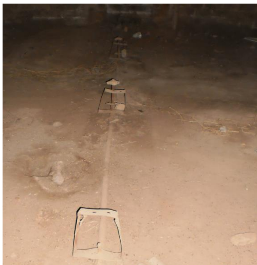
Sistema de quemadores – hongos
