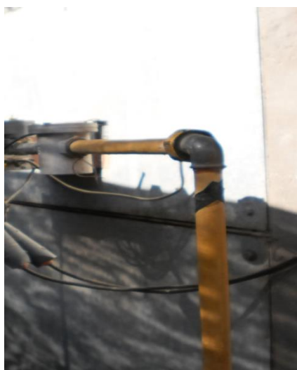
Foto N° 8 Instalación de quemadores de estufa
