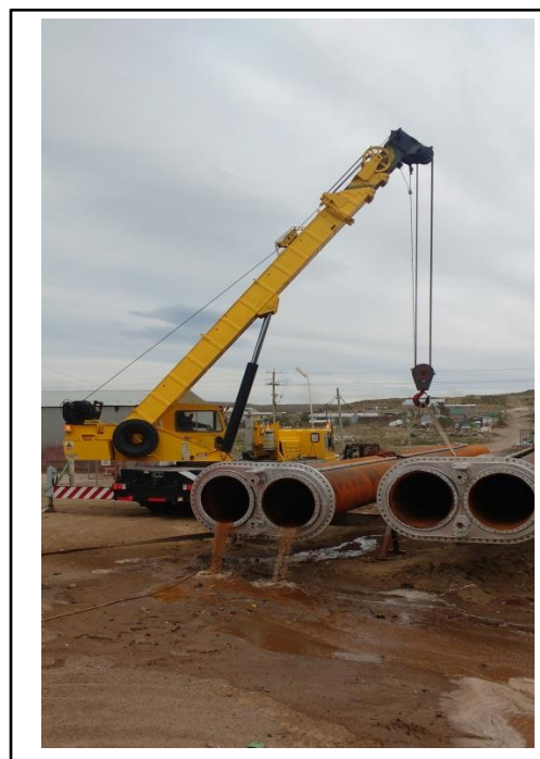
Imagen 46: Corte de calle para izaje. Camino en malas condiciones.
