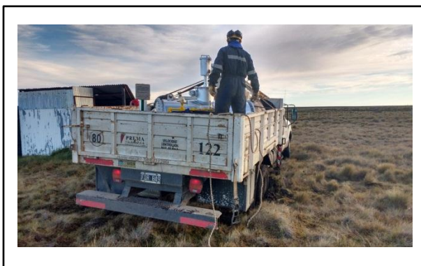
Imagen 17: ingreso de hidrogrúa sin relevamiento visual previo
