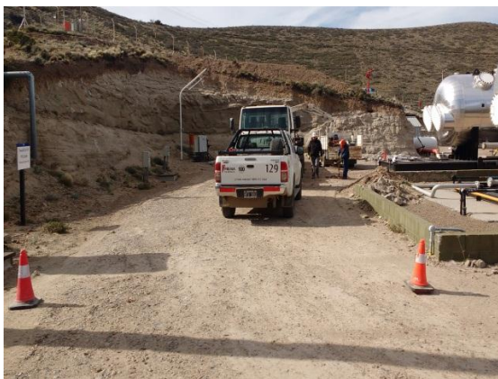
Imagen 124: Llegada al lugar de ejecución
