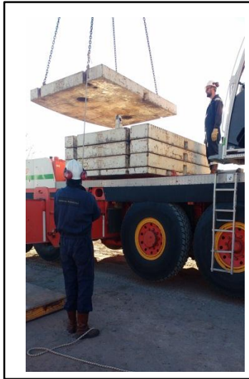
Imagen 68: Colocación de contrapesos
