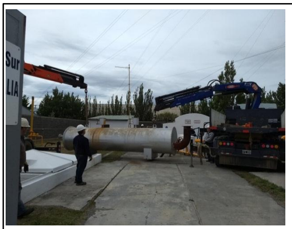
Imagen 84: Izaje y movimiento mediante dos hidrogrúas
