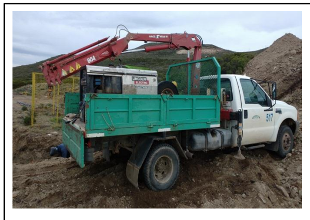
Imagen 97: posicionamiento de hidrogrúa
