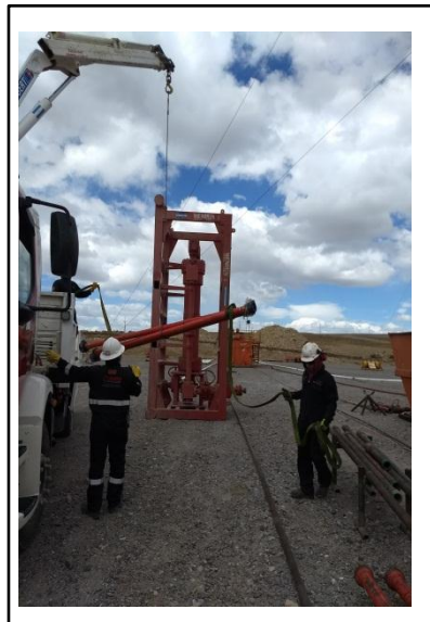
Imagen 105: Descarga y movimiento de cañerías
