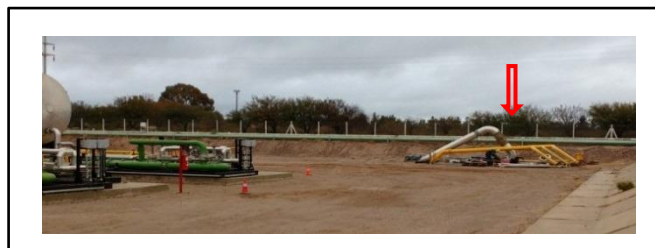
Imagen 22: Caños a ser izados
