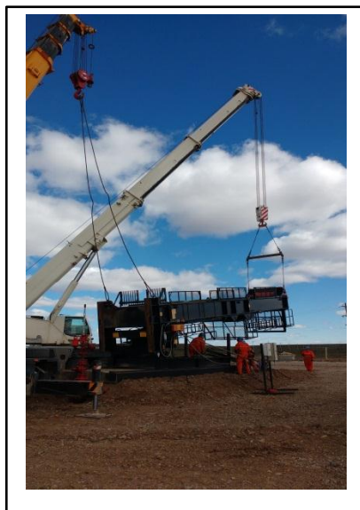
Imagen 51: Posicionamiento de AIB mediante uso de dos grúas
