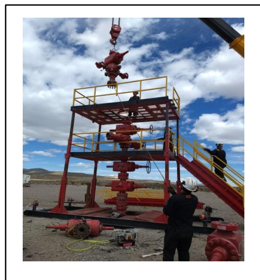
Imagen 37: Montaje de válvula en altura
