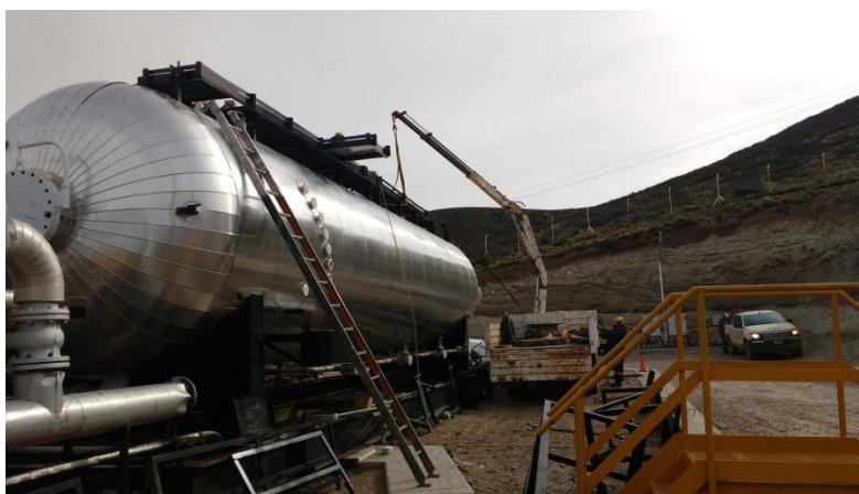
Imagen 128: Izaje de la carga en altura
