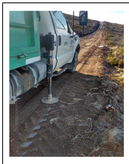
Imagen 94: Falta de colocación de bases adicionales
