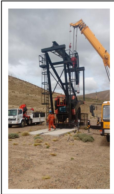
Imagen 31: Montaje de escalera de AIB
