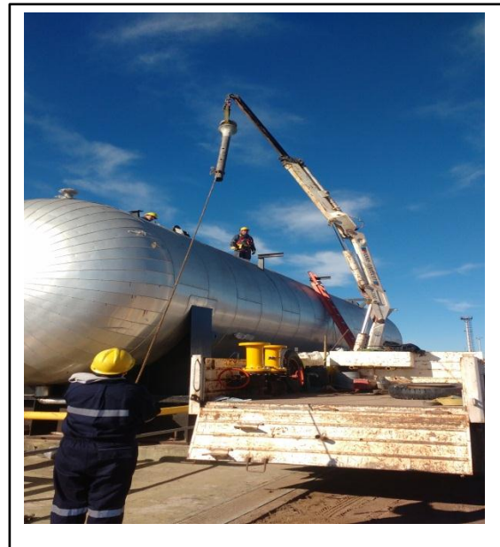
Imagen 118: Izaje de la carga
