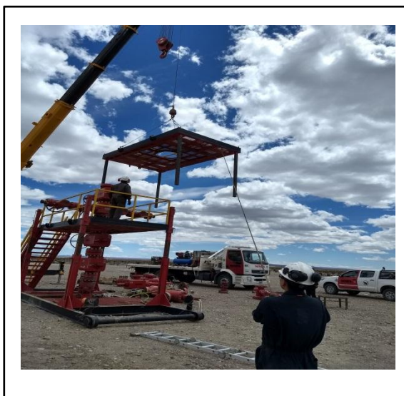
Imagen 36: Trabajador encargado del encaje de la estructura suspendida
