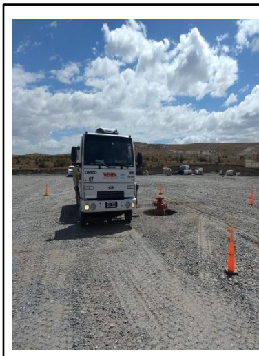
Imagen 111: Posicionamiento de la hidrogrúa
