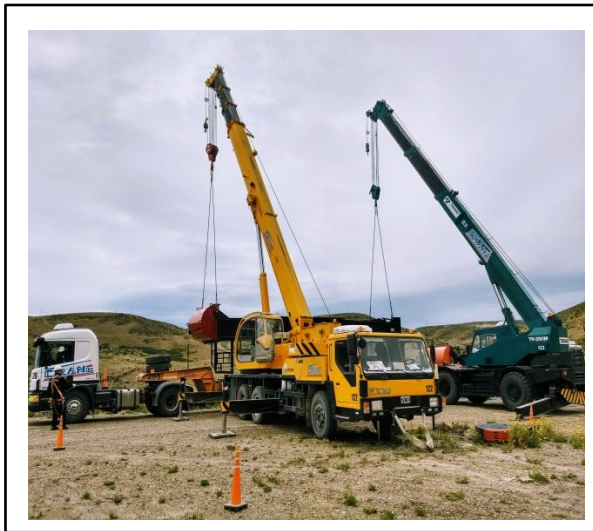
Imagen 49: Carga de AIB sobre camión con dos grúas
