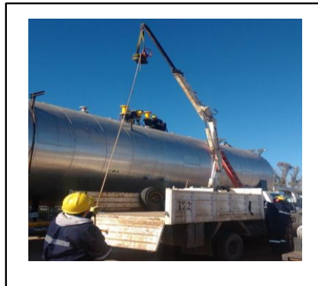
Imagen 23: Montaje de válvula en altura.
