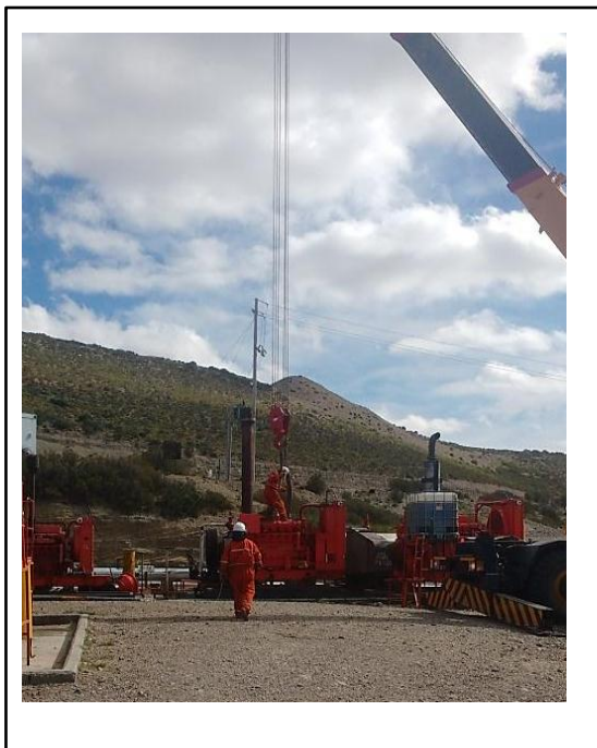
Imagen 40: Eslingado de motor en altura
