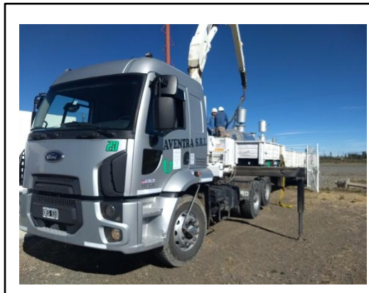
Imagen 88: Posicionamiento de la grúa dentro de planta reguladora
