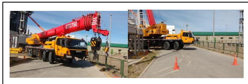
Imagen 24: Posicionamiento de grúa dentro de planta generadora de electricidad.
