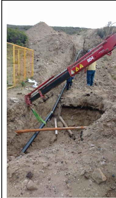
Imagen 99: Izaje de cañerías para ser alineadas y soldadas.
