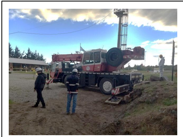
Imagen 58: Posicionamiento de grúa
