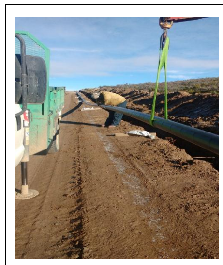
Imagen 95: Izaje de cañerías
