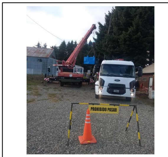
Imagen 61: Izaje de la carga
