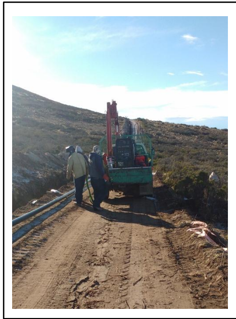
Imagen 92: Hidrogrúa trabajando en camino arenoso
