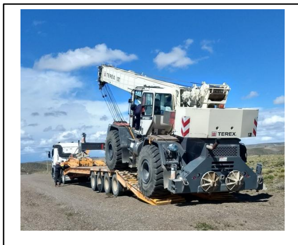
Imagen 16: Grúa subiendo sobre carretón para ser transportada.
