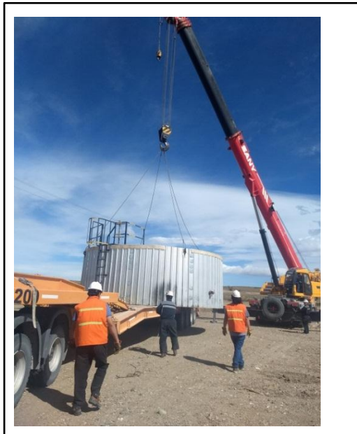
Imagen 56: Descarga de tanque
