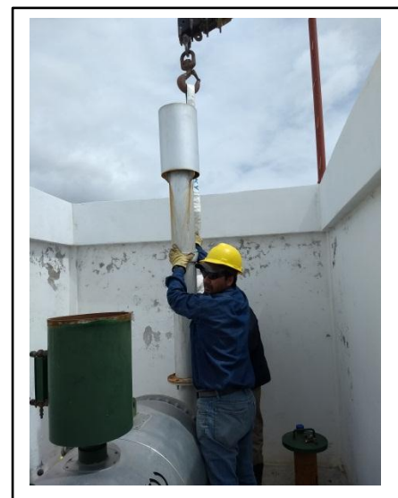
Imagen 91: Montaje de chimenea mediante ayuda de hidrogrúa
