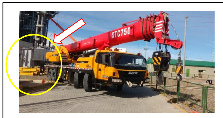
Imagen 47: posicionamiento de grúa cerca de equipo transformador
