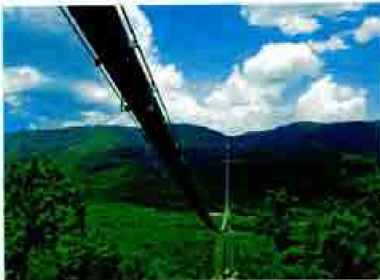
Figura N°33: Cinta transportadora en transporte aéreo
