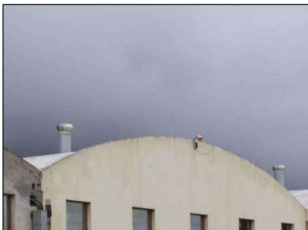
Foto 36: Extractores eólicos en sector de acopios y procesamiento de tabaco.
