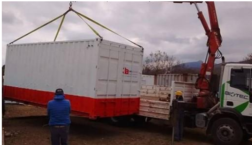
Imagen 3. Módulo oficina construido para la empresa 3A Constructora.
