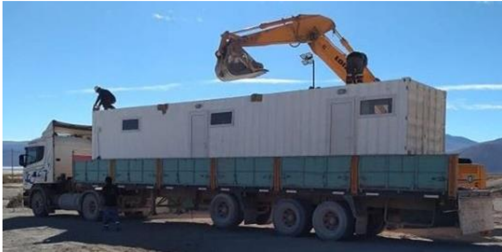
Imagen 6. Módulo sanitario de 40 pies Standard a punto de ser descargado en destino.
