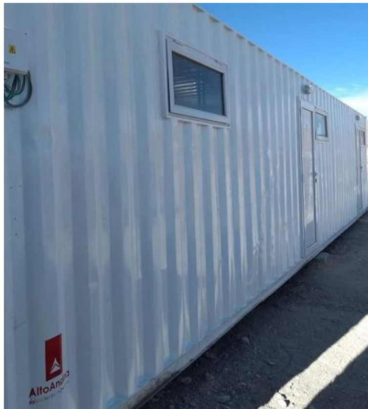
Imagen 7. Módulo sanitario de 40 pies descargado en puesto de control del Salar de Pocitos
