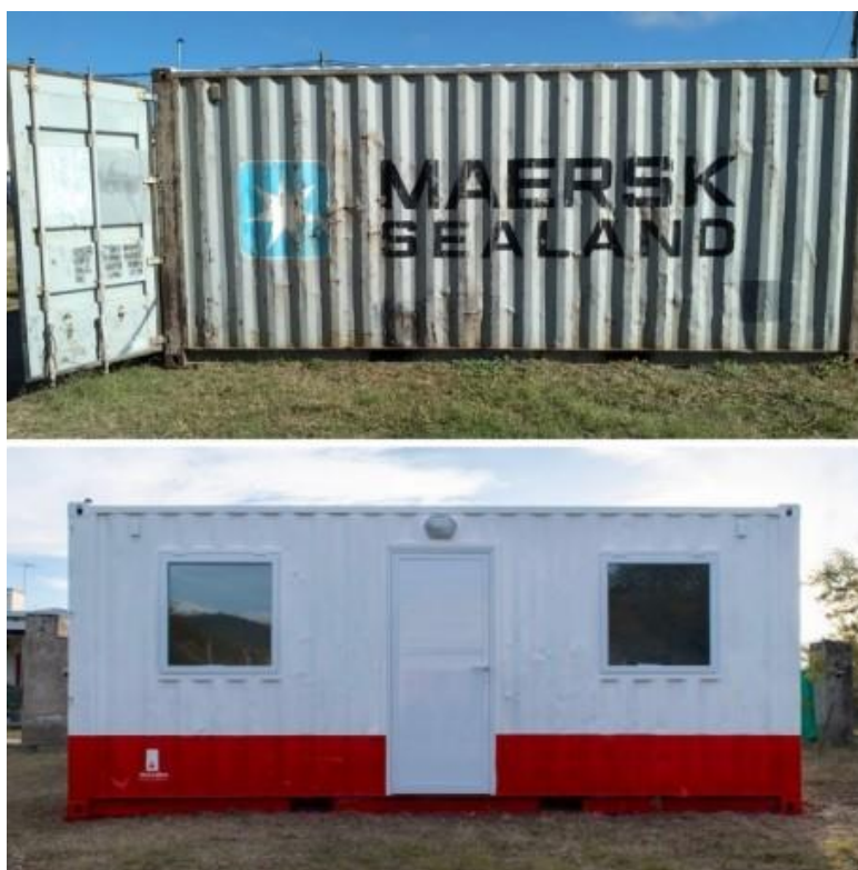
Imagen 1. Contenedor marítimo de 20 pies. Antes y después de ser refaccionado como módulo oficina para minería.
