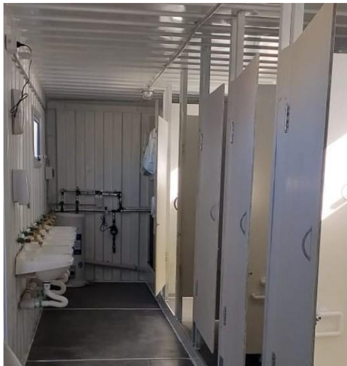
Imagen 9. Interior módulo sanitario 40 pies
