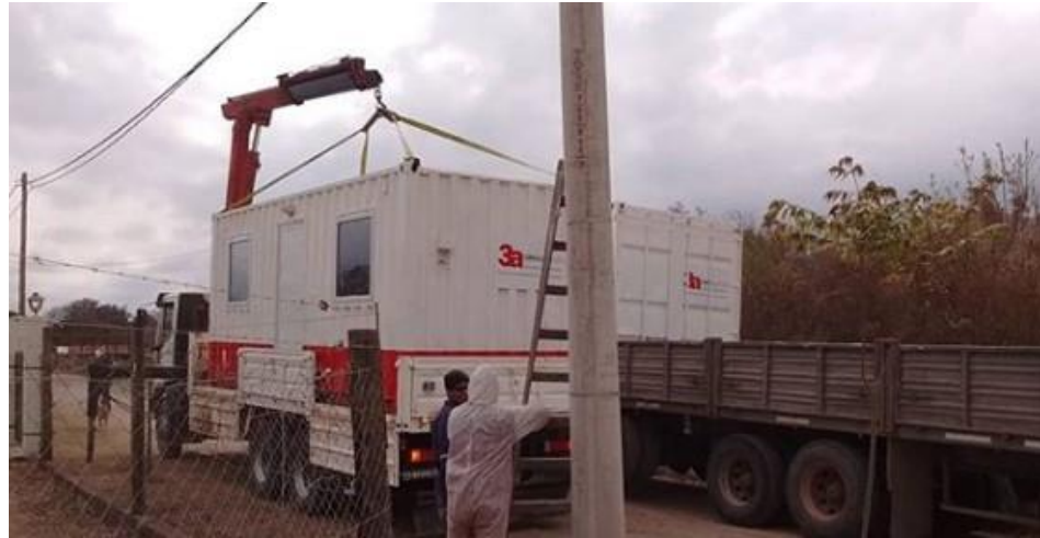
Imagen 2. Carga de módulo oficina en camión para su traslado hacia el proyecto minero “Salar de Centenario-Ratones” ubicado en la Puna de Salta.
