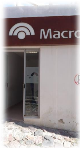
Imagen 40. Fachada de Cajero Automático.
