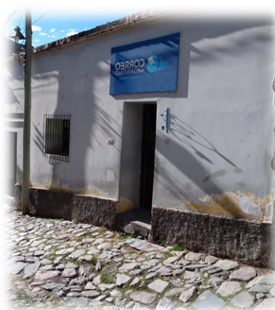
Imagen 39. Fachada del Correo Argentino.
