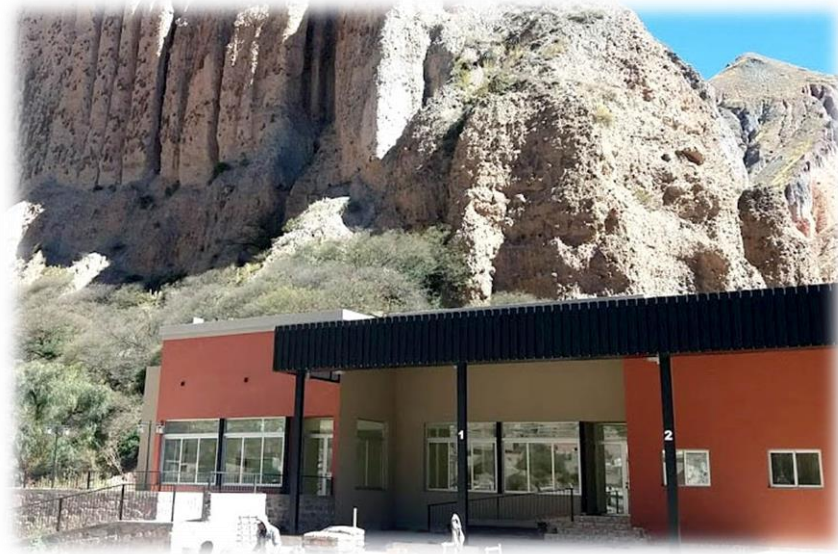
Imagen 13 Fachada de terminal.
