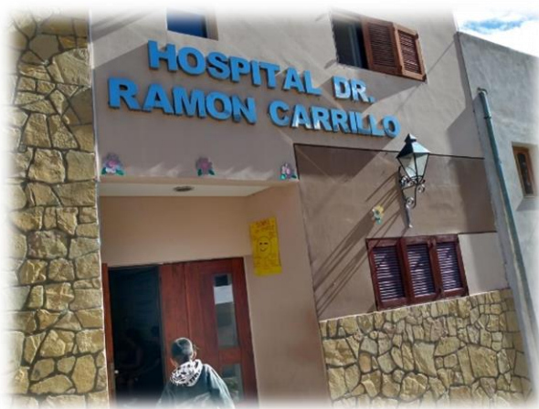
Imagen 41. Fachada del Hospital.
