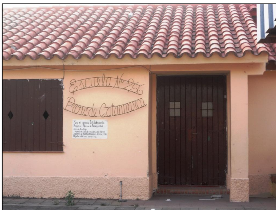
Figura 4: Escuela Primaria N° 266 Provincia de Catamarca. Río Blanco.
