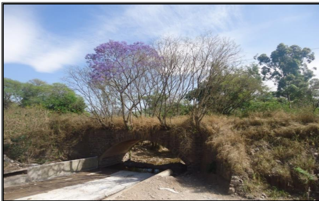
Figura 27: Puente ferroviario sobre el arroyo Río Blanco.
