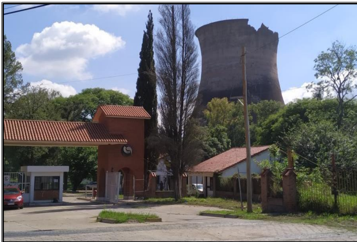
Figura 15: Torres de enfriamiento de la fábrica Aceros Zapla S.A..
