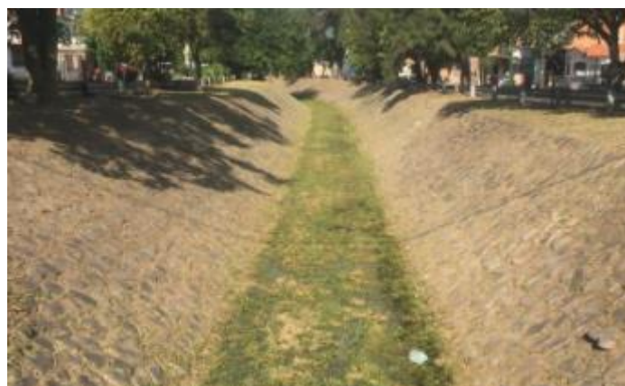
Ilustración 11- Revestimiento Canal Constitución
