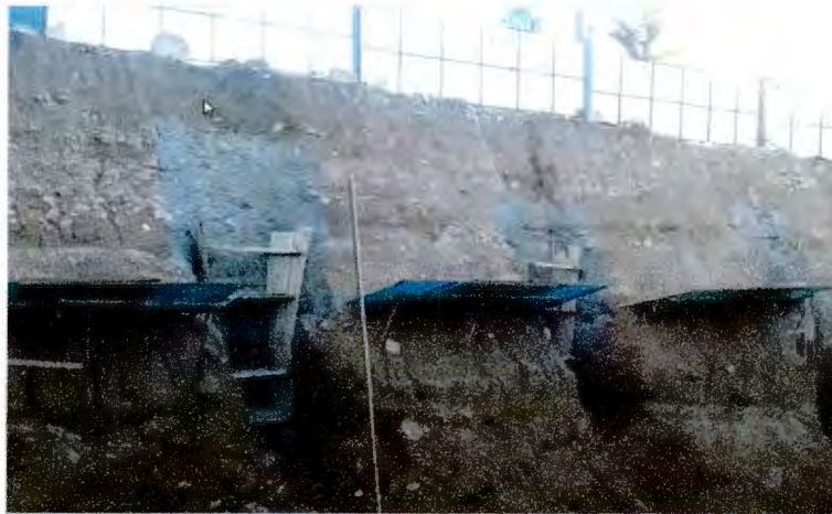
Ilustración A-8 Modelo real de trincheras, condiciones de seguridad
