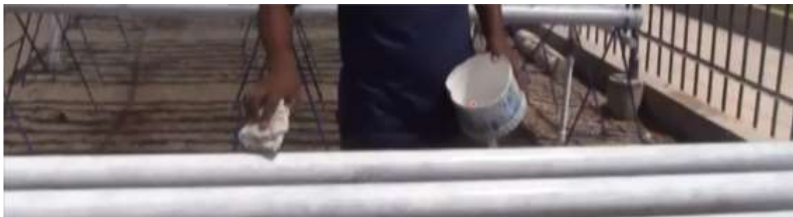
Ilustración 44: Proceso de recubrimiento de los canales de cultivo con pintura blanca
