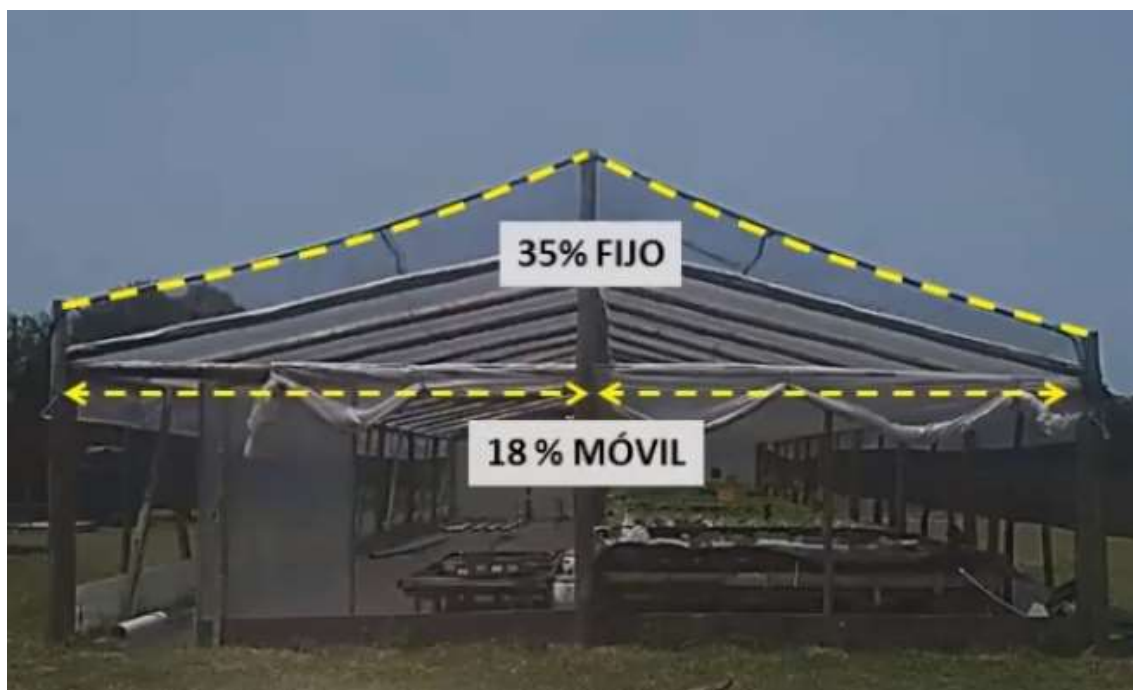
Ilustración 59: Fotografía instalación doble sombreado en invernadero tipo capilla
