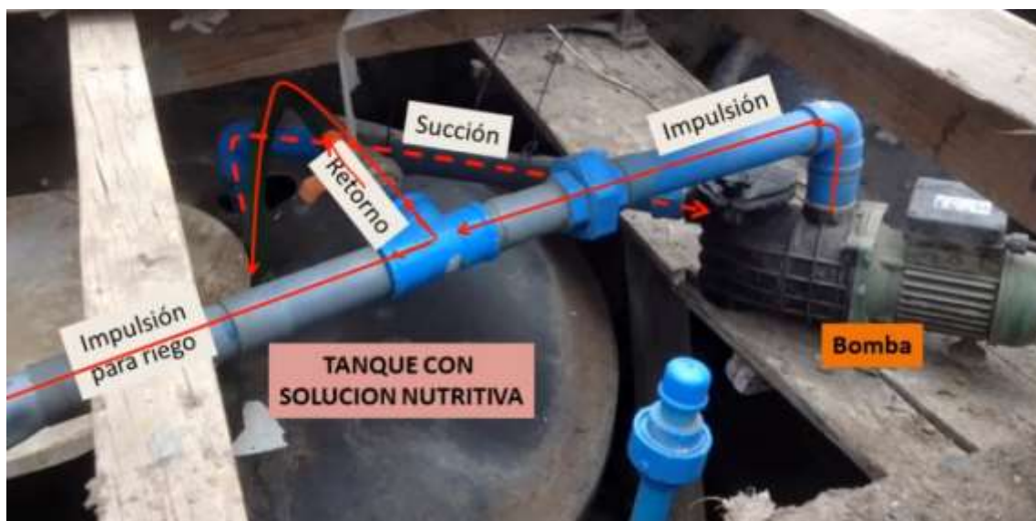
Ilustración 47: Fotografía instalación de bomba
