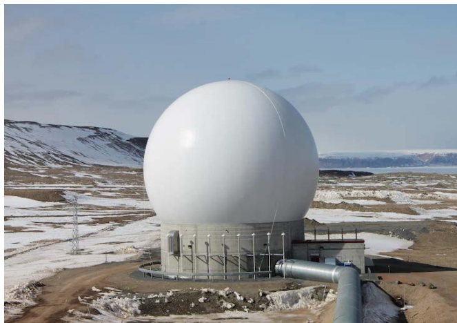
Figura 5-6. Antena en la base aérea de Thule, Groenlandia
