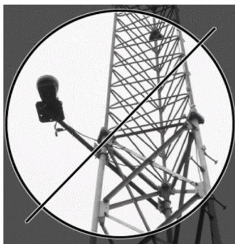
Figura 12-51. Instalación de antena cercana a torre.
