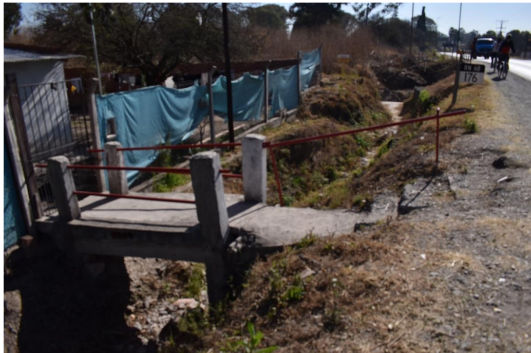
Foto 8-Entrada a la edificación vecina. Estructura de ingreso realizada por el propietario para facilitar el ingreso en inundaciones.
