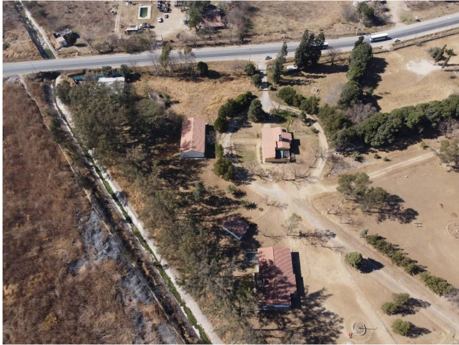
Foto 1-Foto tomada con un drone. Se observa RN68, canalización del Rio Ancho y la zona afectada a los márgenes del mismo.
