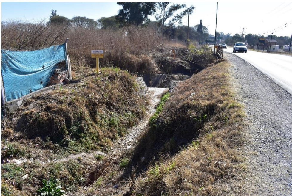
Foto 3-Canal de descarga a la canalización del Rio Ancho, ubicado en la cuneta oeste de RN68.
