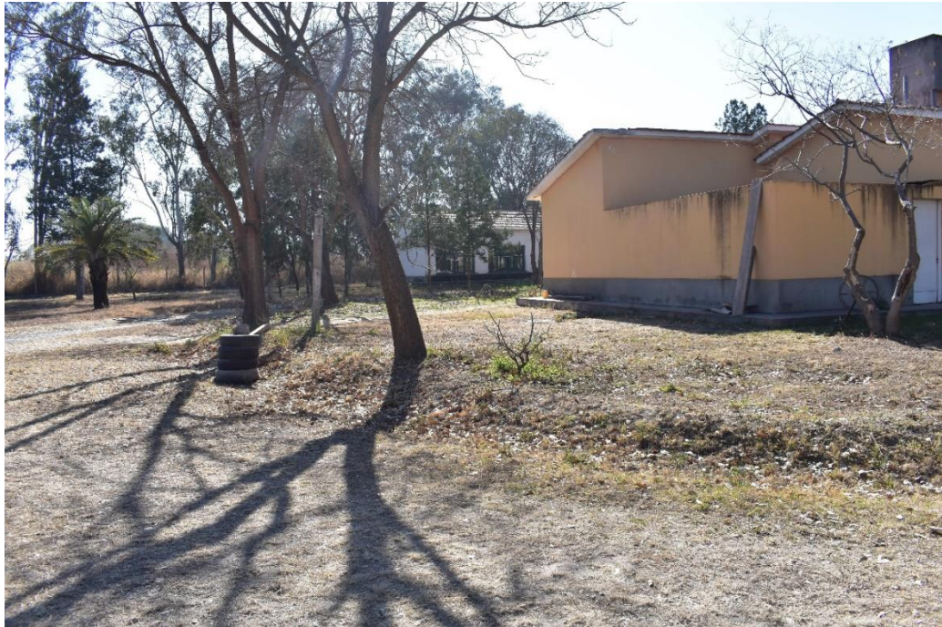
Foto 7-Parte trasera de edificio principal. Se observa una especie de "isla", la cual queda rodeada completamente de agua.
