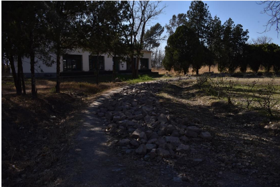
Foto 5-Foto del interior del predio. Se puede observar escombros colocados como mejoramiento del camino de ingreso, afectado por las inundaciones.
