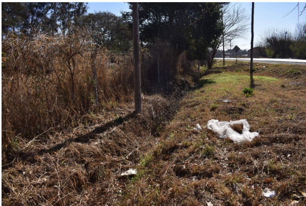
Foto 4-Canal cuneta del lado oeste a RN68. Se puede observar la falta de mantenimiento y limpieza.
