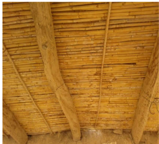
Techo realizado en cañas
