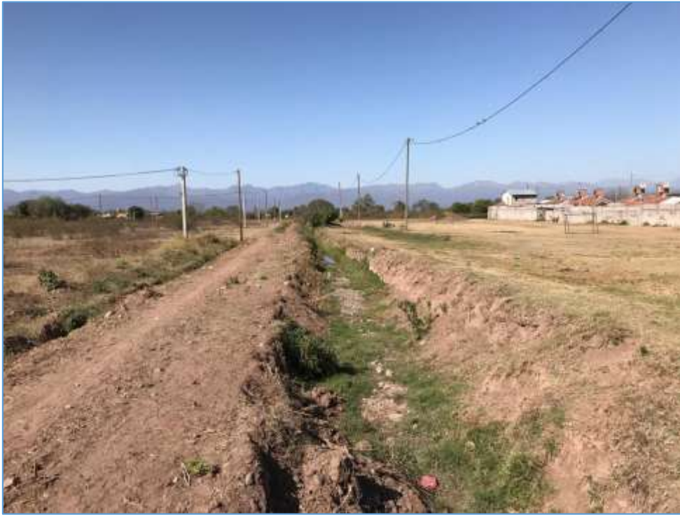
Figura N° 5 Vista hacia el este del canal natural. A la izquierda Loteo Sueños de Chicoana IV.
