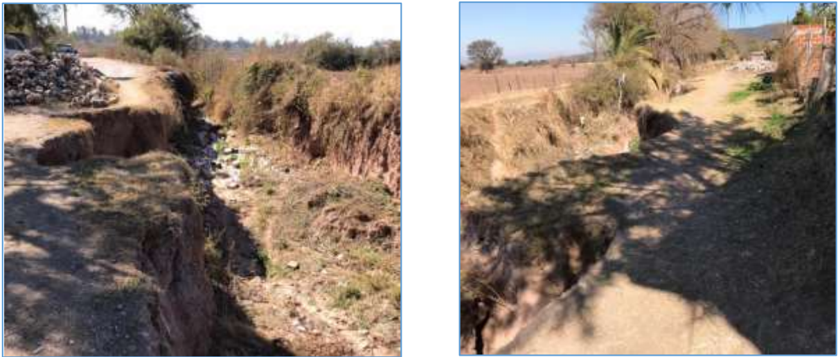
Figura N° 43 Situación del Tramo 4, antes de la construcción del canal existente.
