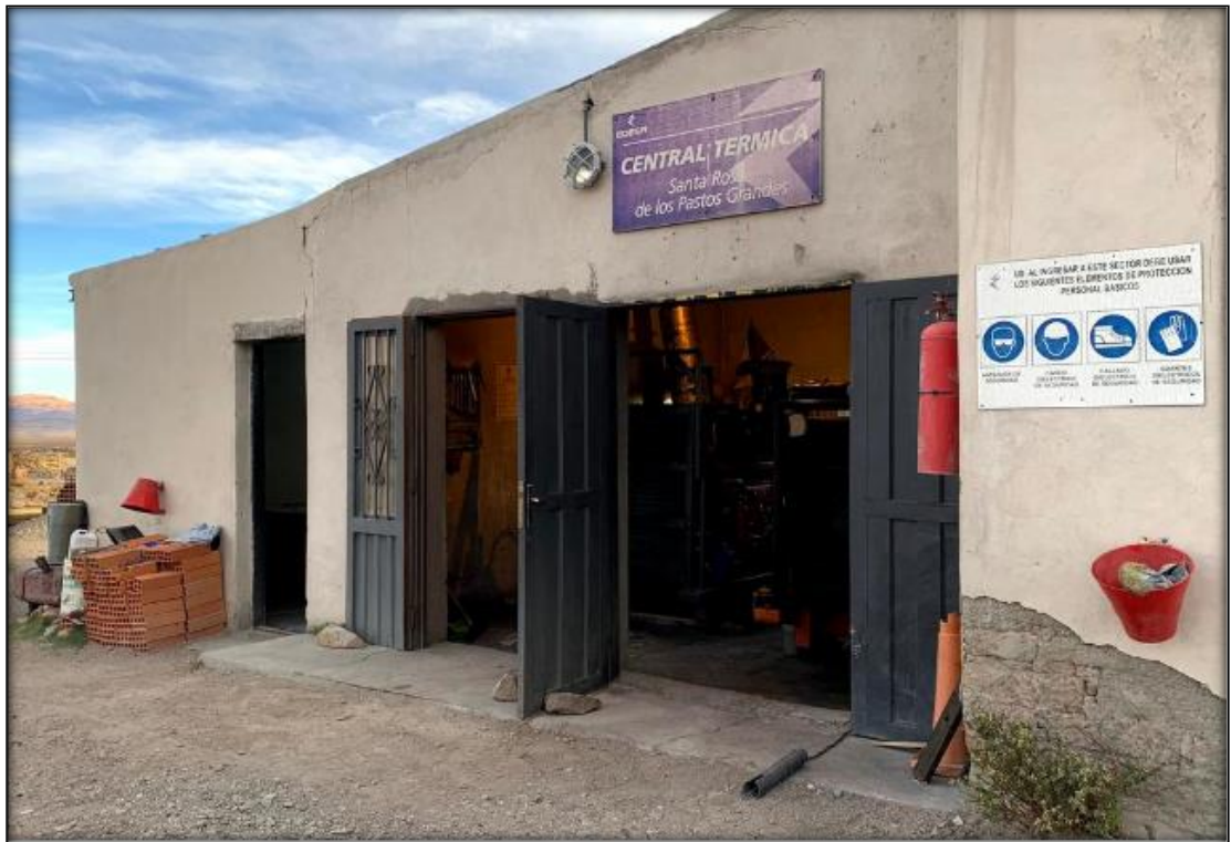
Ilustración 2. Central térmica Santa Rosa de los Pastos Grandes
