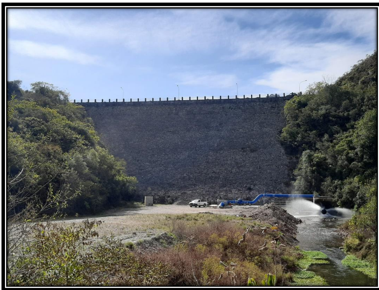
Ilustración 1: Presa del embalse Campo Alegre vista desde aguas abajo.
