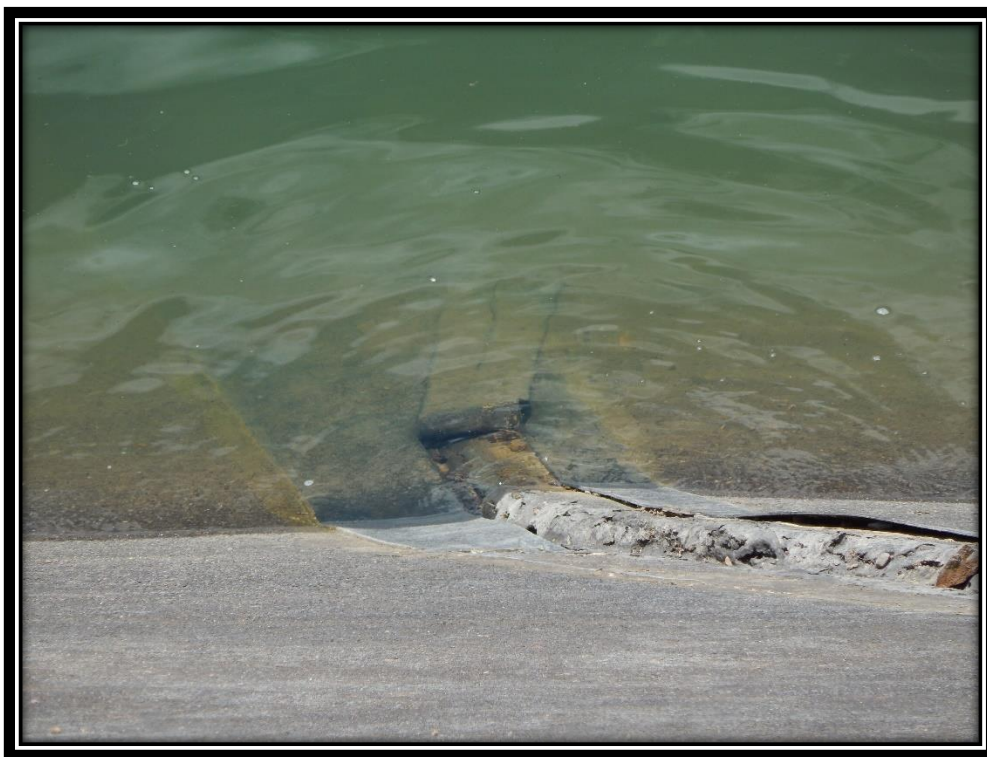
Ilustración 117 Reparación de junta perimetral, apoyo de pantalla sobre el plinto.
