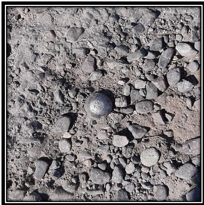
Ilustración 14: Bulón en eje de coronación de la presa.
