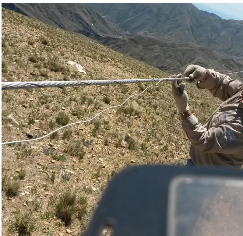
Imagen 44 : Reparación de HG
