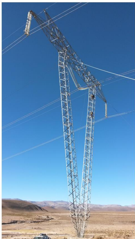
Imagen 50 : Trabajadores ascendiendo a torres de suspensión para cambio de aisladores
