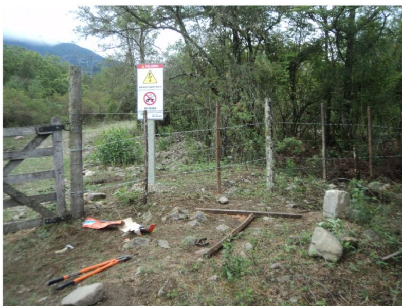
Imagen 42 : Trabajadores realizando cambio de carteleria en tranquera de acceso
