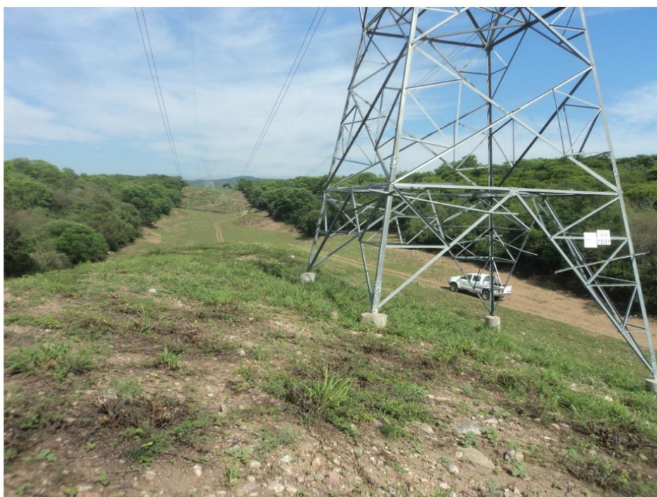
Imagen 23 : Inspección de línea
