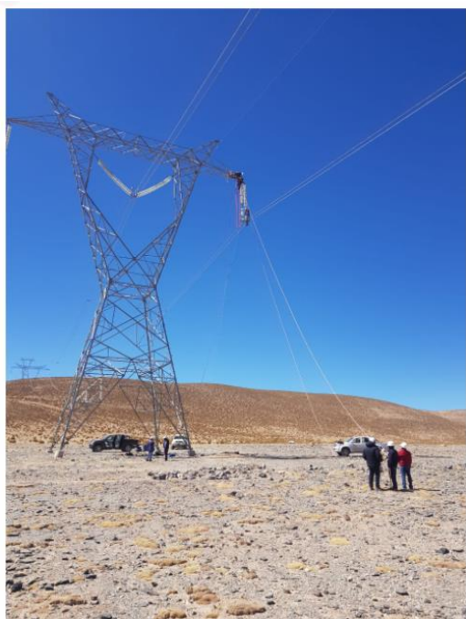
Imagen 34 : Trabajadores realizando cambio de aisladores
