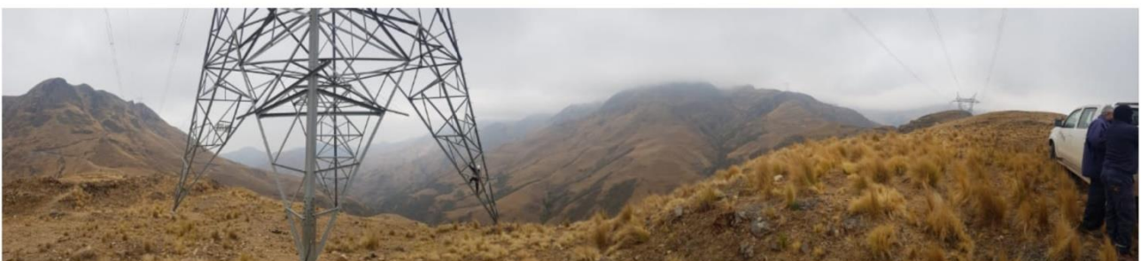
Imagen 27 : Trabajador ascendiendo a torre de alta tensión
