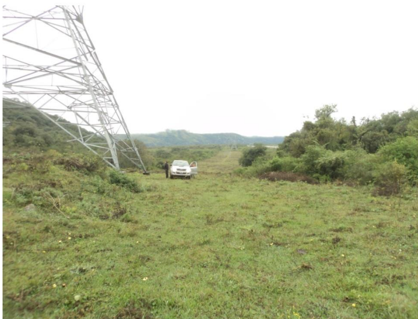
Imagen 24 : Personal realizando inspección a pie
