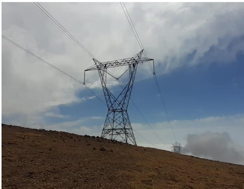
Imagen 40 : Trabajadores ascendiendo a torre
