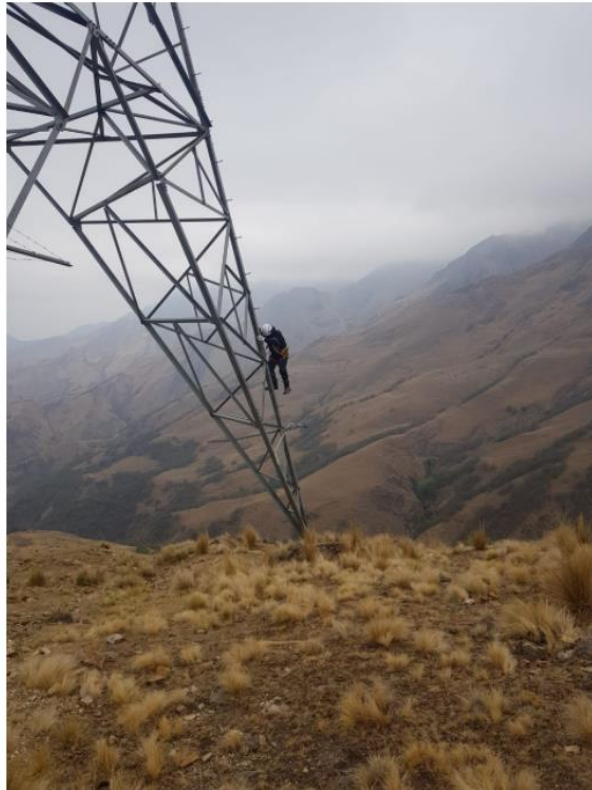
Imagen 27 : Trabajador ascendiendo a torre
