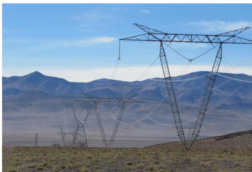
Imagen 38 : Torres cercas donde se puede realizar inspecciones a pie
