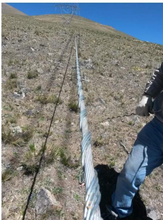
Imagen 45 : Reparación y tendido de HG
