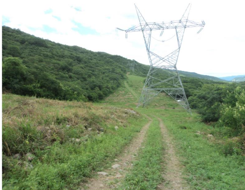
Imagen 22 : Inspección de Línea por caminos cercanos
