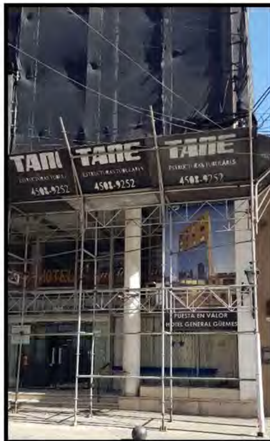
Figura 25. Sistema de andamio modular multidireccional
