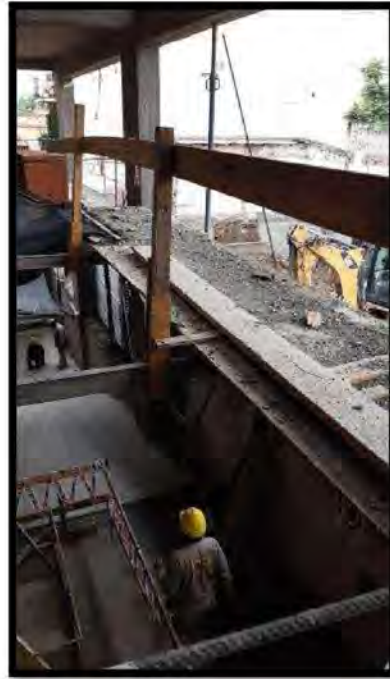
Figura 40. Baranda de madera zunchada con alambre
