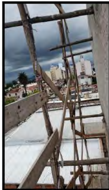
Figura 79. Travesaños de palo bobo empotrados en muro.
