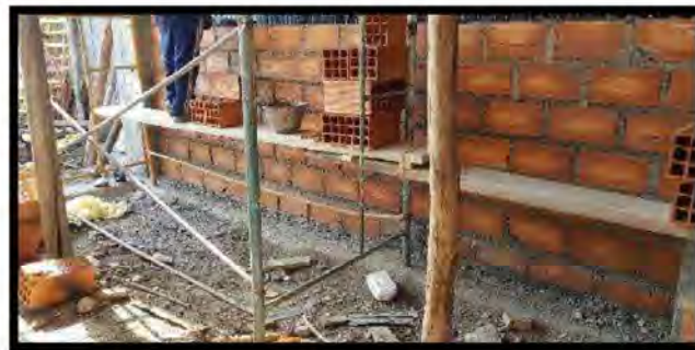
Figura 45. Plataforma apoyada en los escalones inferiores de la escalera de montantes
