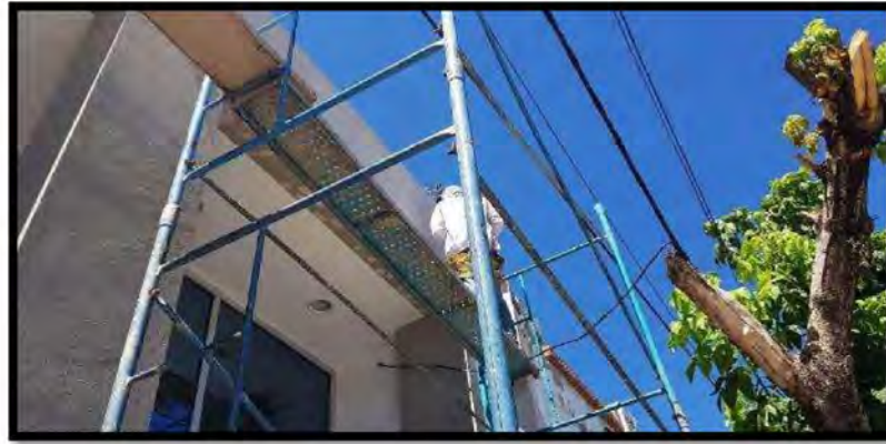
Figura 29. Andamio con plataforma metálica
