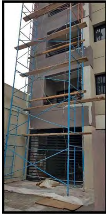
Figura 49. Andamio modular metálico
