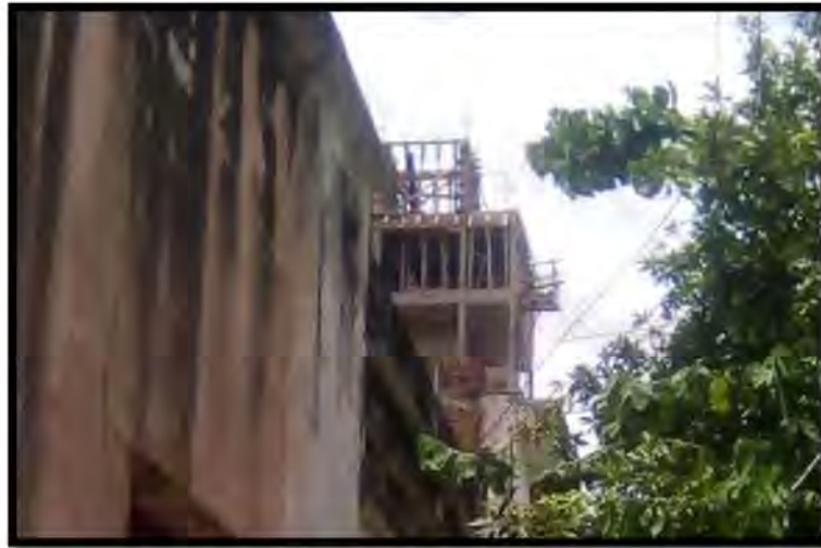
Figura 6. Andamio de madera en voladizo (calle General Güemes al 1400 Ciudad de Salta)
