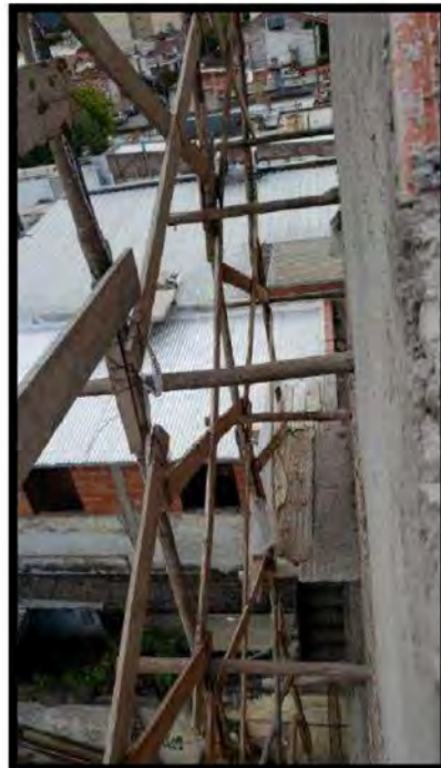
Figura 59. Empotramiento de los travesaños en la pared de fachada
