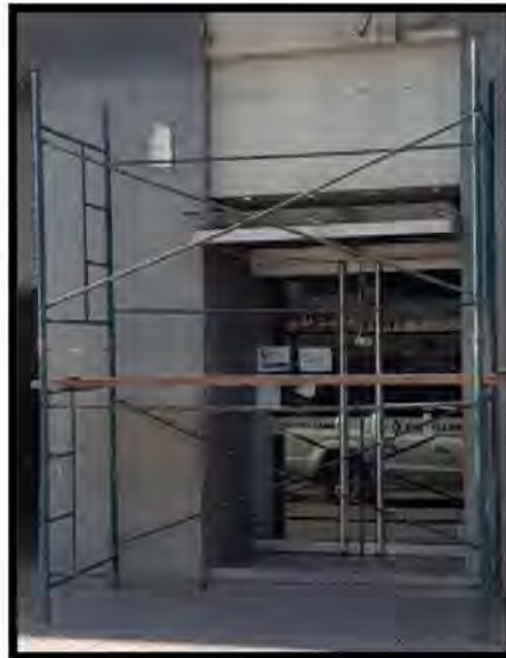
Figura 9. Pintura de fachada (calle Rioja al 400 Ciudad de Salta)
