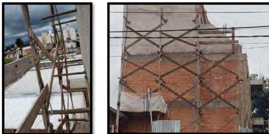
Figura 27. Montantes de puntales de palo bobo
