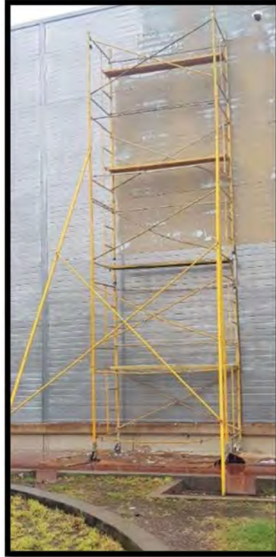
Figura 19. Andamio modular metálico con plataformas metálica (Súper Libertad)
