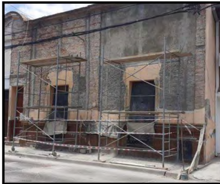
Figura 55. Par de andamios para revoque de una fachada
