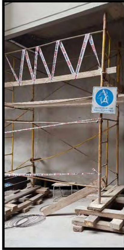
Figura 54. Andamio metálico apoyado sobre tarima de madera
