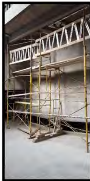
Figura 52. Andamio modular metálico montado sobre una base de ladrillos
