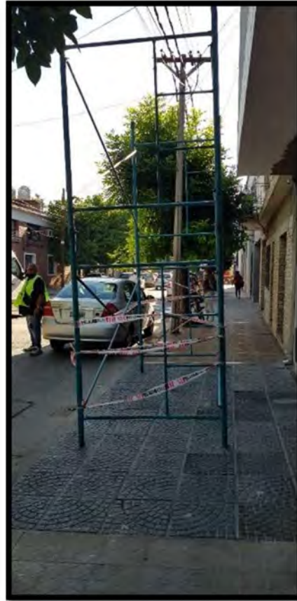
Figura 21. Andamio modular simple
