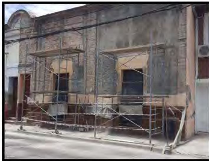
Figura 4. Rehabilitación de fachada (calle San Juan al 400 Ciudad de Salta)
