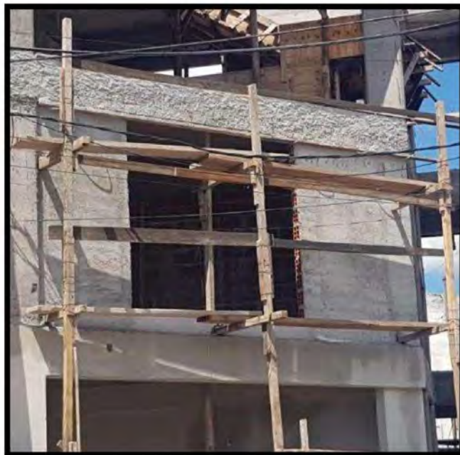
Figura 20. Andamio de madera (Av. Entre Ríos)
