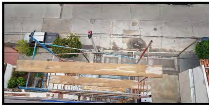
Figura 77. Andamio de metálico con plataformas de tablonces de madera.
