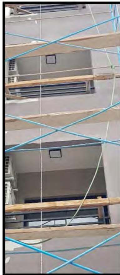
Figura 36. Sujeción de travesaño con puntales de madera en baranda metálica
