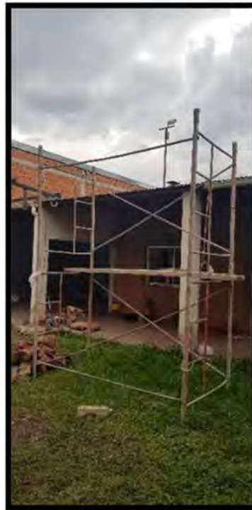
Figura 30. Andamio con plataforma de madera
