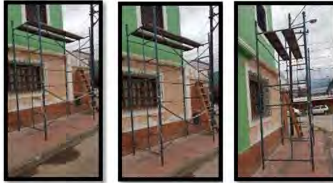
Figura 51. Andamio modular metálico con plataforma metálica
