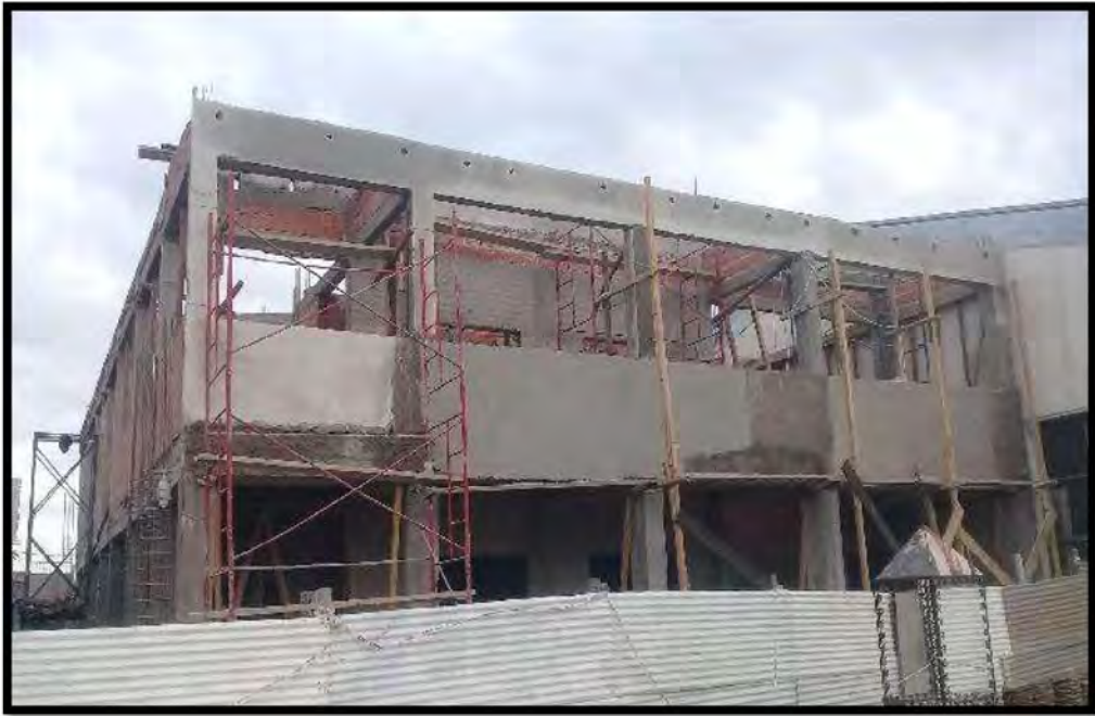
Figura 58. Sistema de andamios mixto de madera y estructura modular metálica
