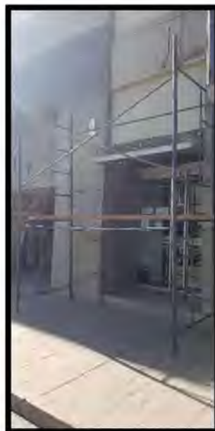
Figura 46. Andamio tubular montado con escaleras intercaladas
