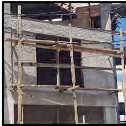
Figura 5. Andamio de madera (calle Entre Ríos al 1700 Ciudad de Salta)
