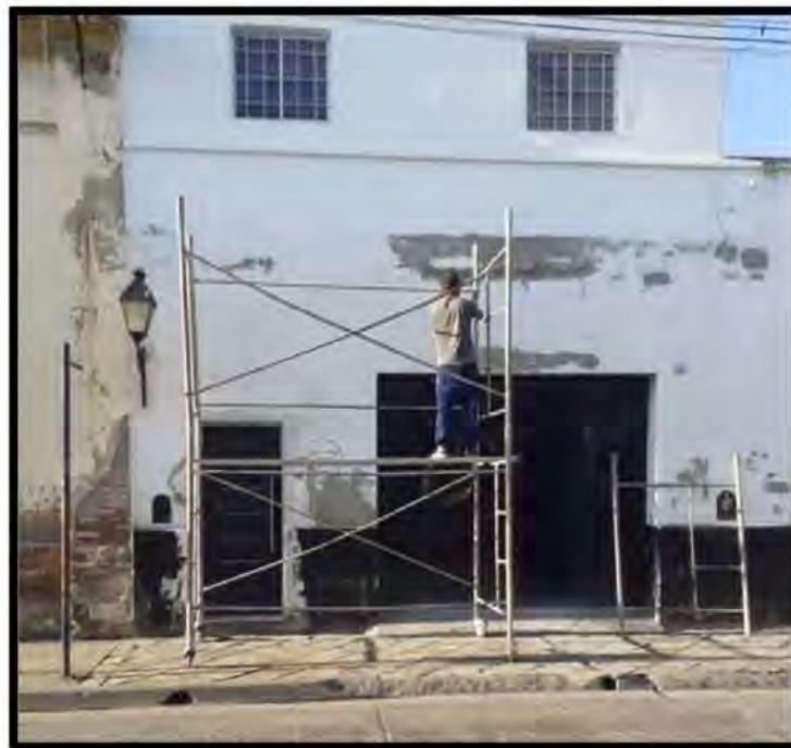
Figura 53. Operario trabajando en el montaje del andamio
