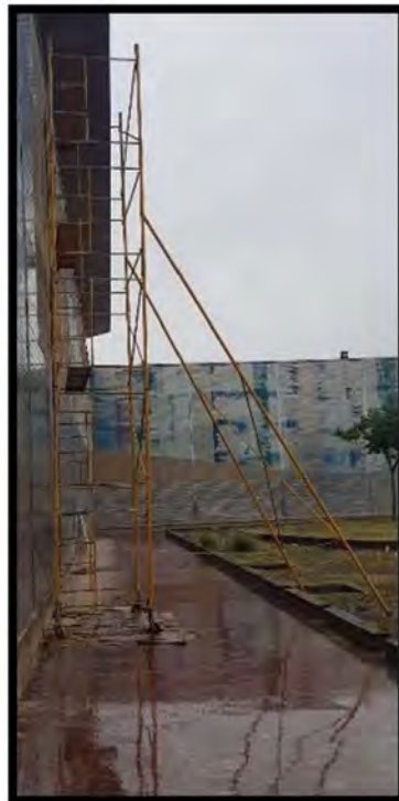
Figura 44. Andamio tubular con escalera junto a fachada
