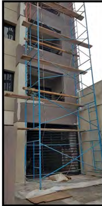
Figura 32. Andamio con sistema provisional de sujeción con soga
