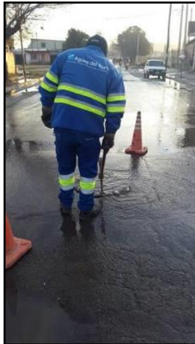
Ilustración 7. Trabajador removiendo tapa de boca de inspección para identificar el problema. 10
