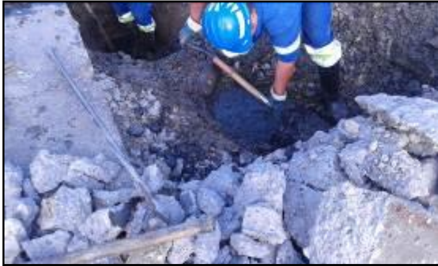
Ilustración 14. Excavación y remoción de material excedente. 17
