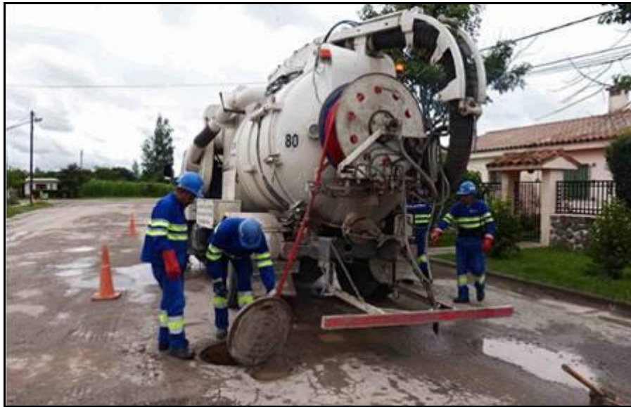
Ilustración 36. Señalización con conos en zona de trabajo 48
