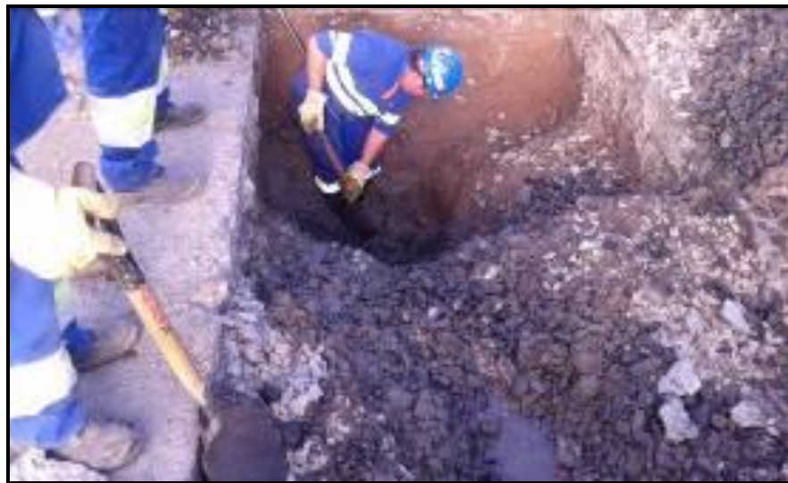
Ilustración 11. Trabajadores realizando tareas de excavación 14
