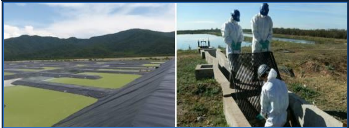
Ilustración 5. Planta depuradora o sistema de tratamiento de lagunas de estabilización 5
