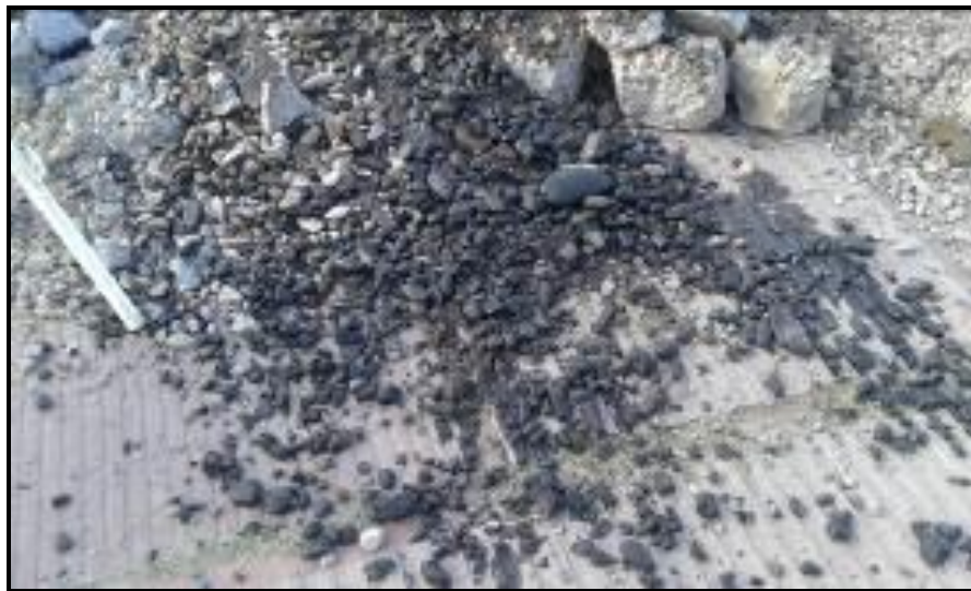
Ilustración 15. Presencia de agua séptica. El color negro indica un estado de descomposición avanzado. 18
