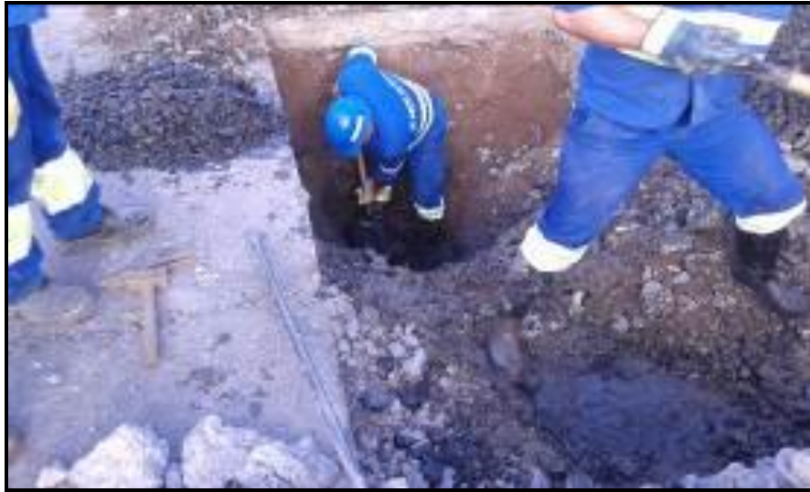
Ilustración 12. Operarios drenando la excavación realizada 15
