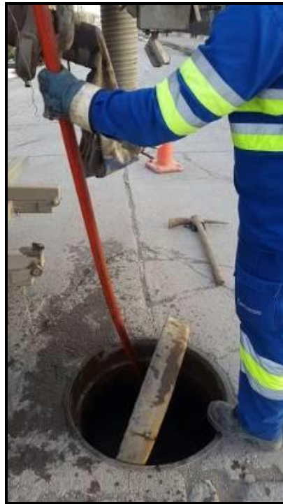
Ilustración 9. Personal extrayendo manguera de alta presión de la boca de inspección. 12
