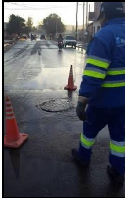
Ilustración 6: Señalización de zona de trabajo. 9
