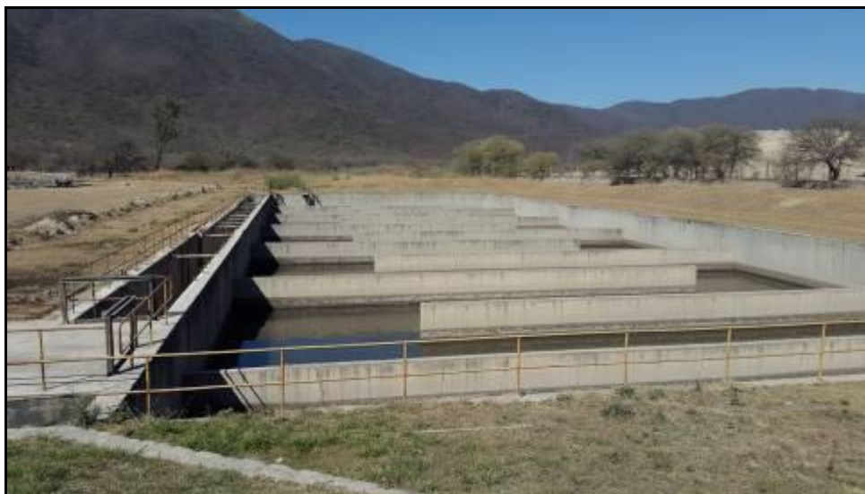
Ilustración 33. Piletas de tratamiento de efluentes cloacales 45
