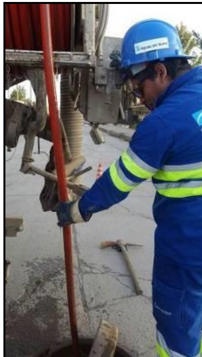
Ilustración 8. Proceso de desobstrucción o limpieza hidrocínética. 11
