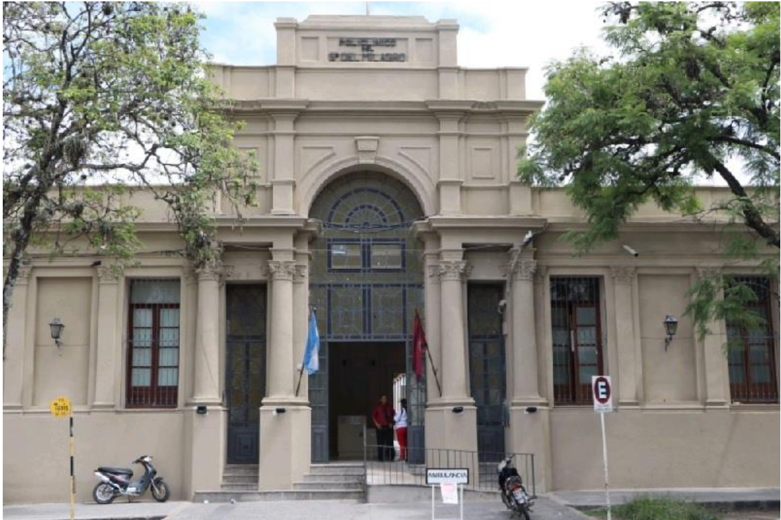
Imagen 2: Hospital Señor del Milagro- Ingreso principal
