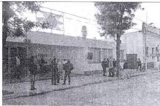
El edificio municipal de Rosario de la Frontera, a un costado la comisaría 31.
