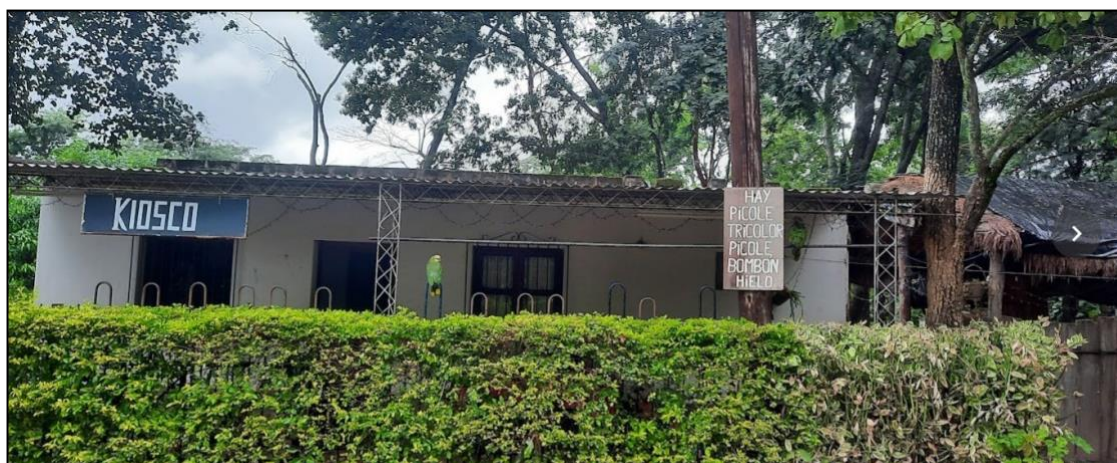
Foto 12. Infraestructura de apoyo al Sendero a la Cruz
