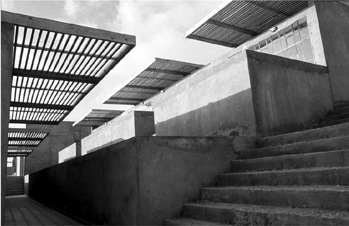
Fig. 4. Glenda Kapstein, Casa de retiro. Celdas
