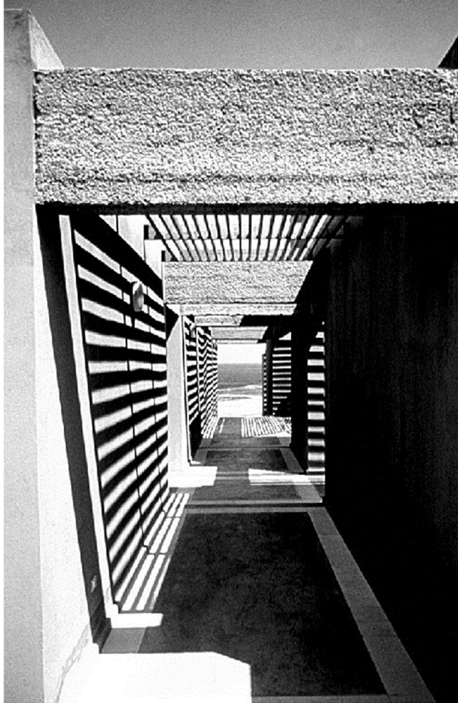
Fig. 3. Glenda Kapstein, Casa de retiro. Corredor cubierto con sombreadero de madera, de los espacios de reunión colectivos
