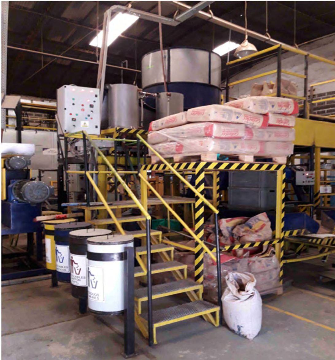
Fig. 5 - Tanques de agua caliente.
