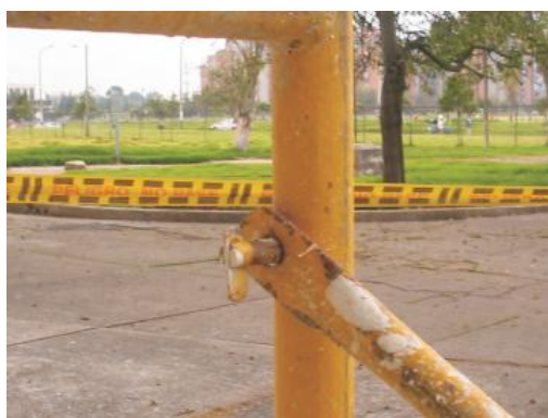
Figura 4. Forma de asegurar crucetas
