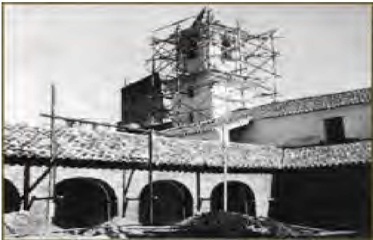
Figura 44: Construcción de la torre del Cabildo Salta 1797.
