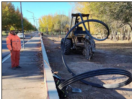
Figura 30. Tendido soterrado de fibra óptica
