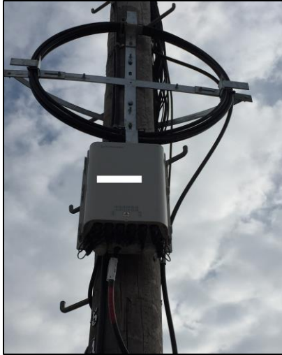
Figura 28. Tendido aéreo de fibra óptica
