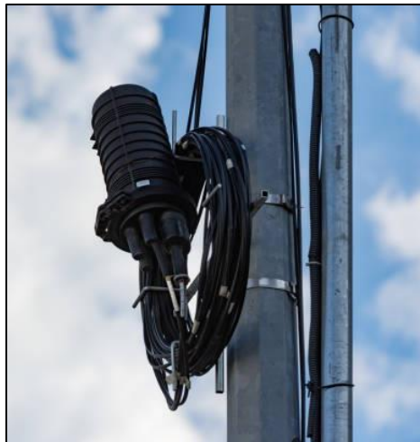
Figura 29. Tendido aéreo de fibra óptica
