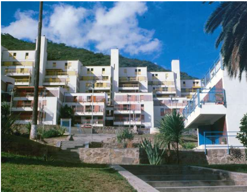
Fig. 17 - Imágenes extraídas de https://www.miguelangelroca.com.ar/conjunto-san-bernardo
