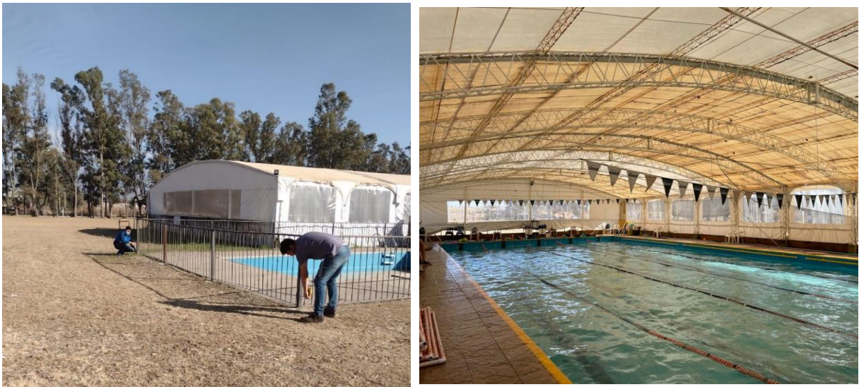
III – Fig. N°2: Pileta y sus alrededores construida.
