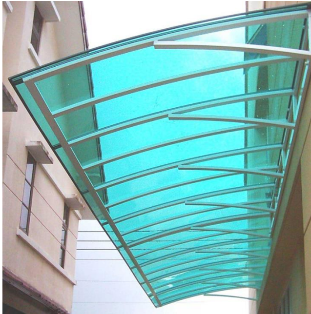
V – Fig. N°1: Estructura con policarbonato compacto
