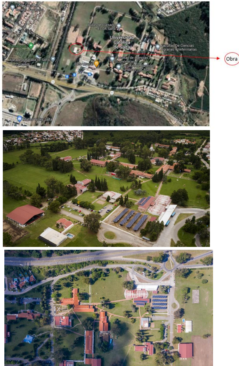
III – Fig. N°1: Ubicación de la Obra.
