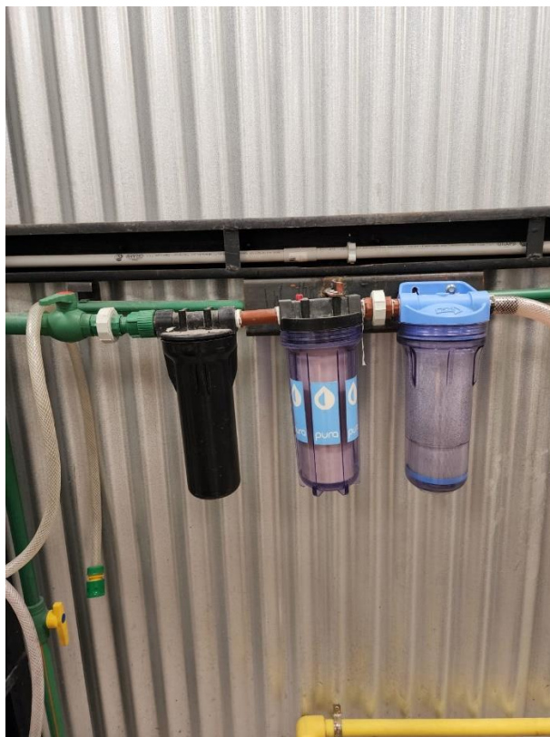
Ilustración 82. Equipo de Purificación de Agua con Carbón Activado
