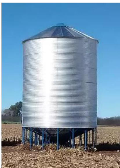
Figura 22: Silo de almacenamiento.
