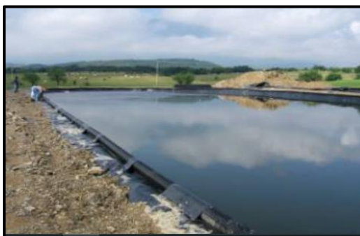
Figura 17-Tubería alrededor de la laguna, cuya función es la captación del biogás que se generará en cuanto se cubra la laguna
