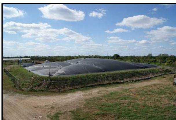
Figura 18 - Geomembrana expandida
