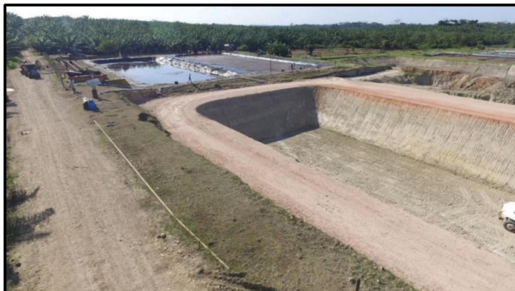
Figura 9 - Construcción de pozo y taludes de la laguna
