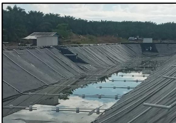
Figura 16 - Colocación de la geomembrana para cubrir el fondo de la laguna y tuberías necesarias para la succión de lodos residuales
