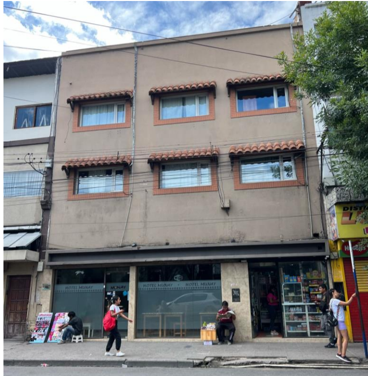
Ilustración 2. Fachada frontal del hotel Munay.
