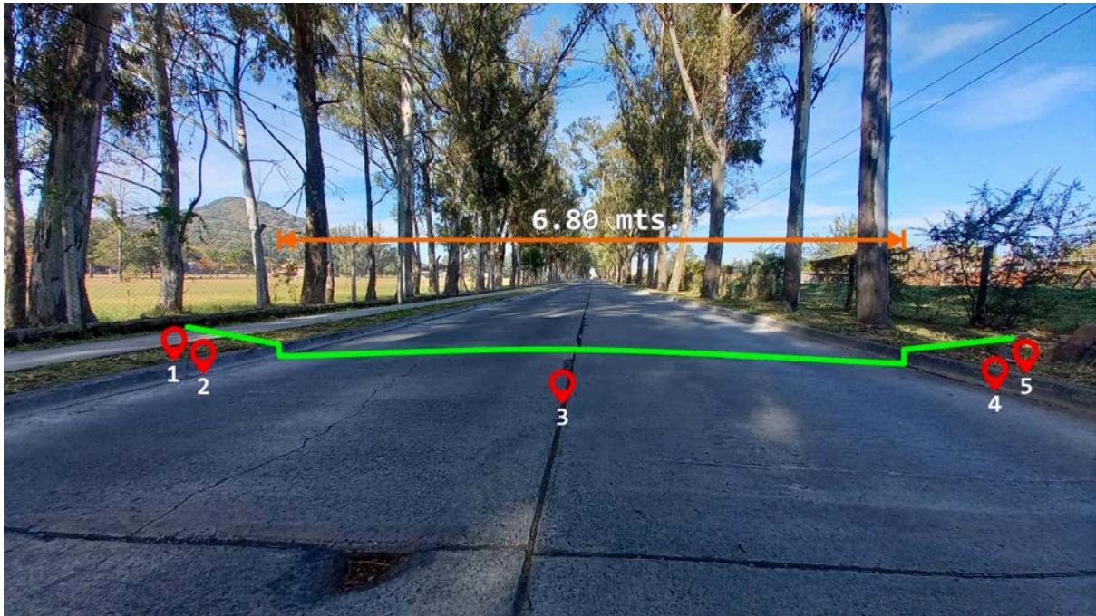
Fig. 56: Muestra de los puntos tomados en una sección de la calle San Andrés Apóstol para determinar el perfil transversal tipo de la misma.
