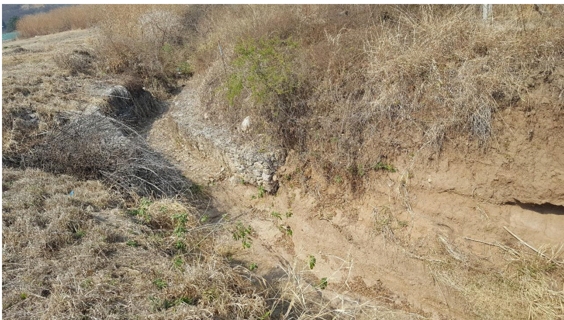
Fig. 16: Imagen del canal tomada en la zona noreste del Campus.
